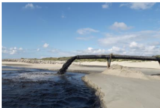
Trabalhos de dragagem no Canal de Mira no troço 4.6 (acesso ao cais dos pescadores da Costa Nova) e zona de repulsão de dragados no mar.
