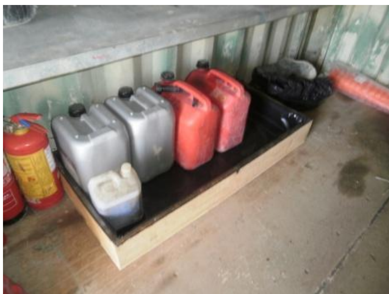
Evidência do cumprimento da Medida de minimização n.º 29 – armazenamento de substâncias perigosas
