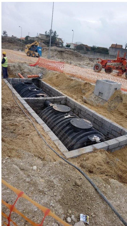
Evidência do cumprimento da Medida de minimização n.º 31 – Recolha das águas residuais domésticas das fossas estanques para encaminhamento para a AdRA
