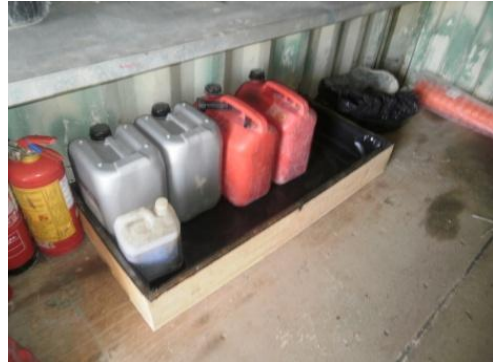
Evidência do cumprimento da Medida de minimização n.º 26 – correta gestão e armazenamento de resíduos perigosos e não perigosos
