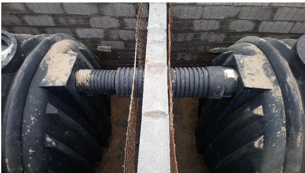
Evidência do cumprimento da Medida de minimização n.º 32 – Instalação dos separadores de hidrocarbonetos
