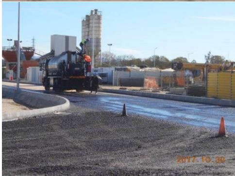
Evidência do cumprimento da Medida de minimização n.º 25 – rega com joper das vias de circulação afetas à obra
