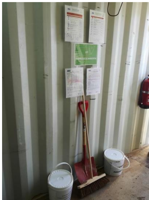
Evidência do cumprimento da Medida de minimização n.º 21 e 30 – armazenamento de solos contaminados para posterior envio para OGR
