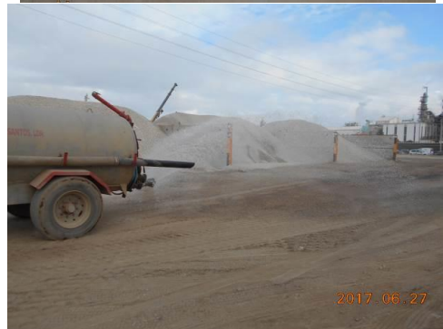
Evidência do cumprimento da Medida de minimização n.º 25 – rega com joper das vias de circulação afetas à obra
