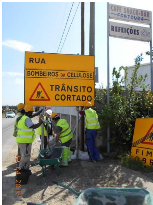
Evidência do cumprimento da Medida de minimização n.º 24 – sinalização de obras na via pública
