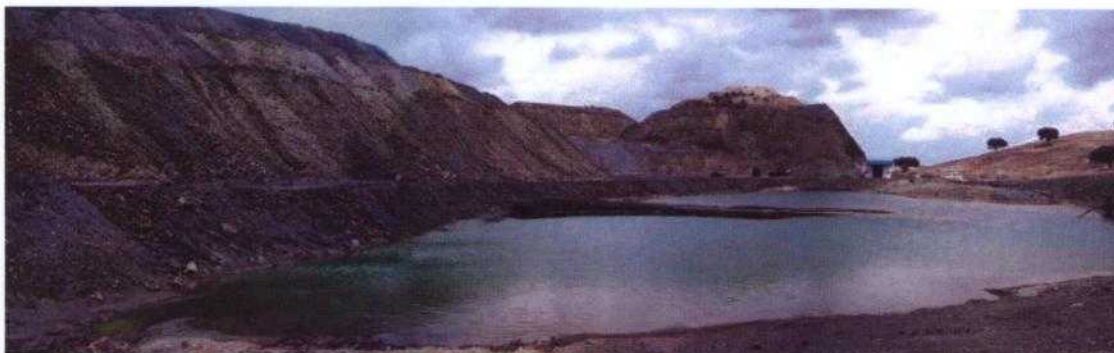
Figura 1 - Aspecto da Barragem de Águas Contaminadas junto às escombreiras
