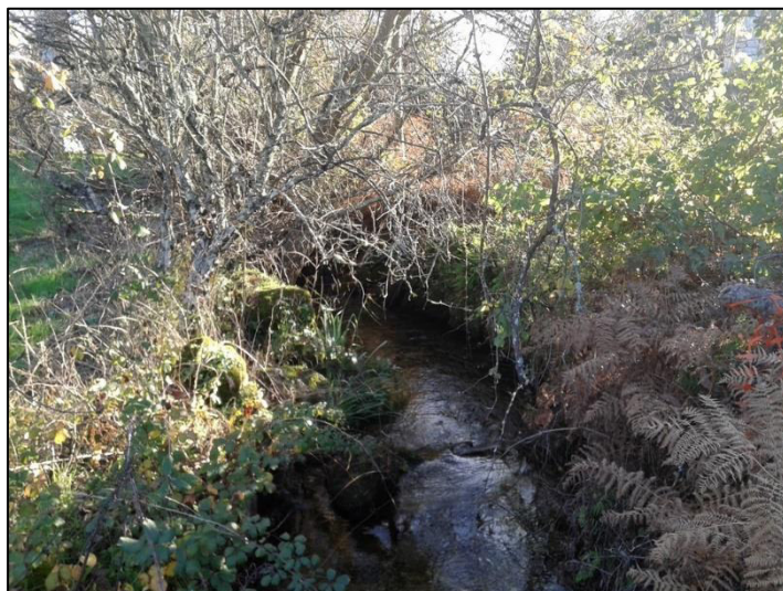
Figura 13 – Lote 7 - S6J - Ribeiro do Cortiço, Viaduto 1, a jusante da via
