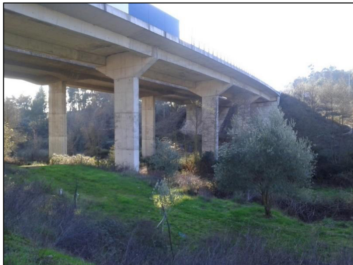
Figura 12 – Lote 7 - S6M - Ribeiro do Cortiço, Viaduto 1, a montante da via
