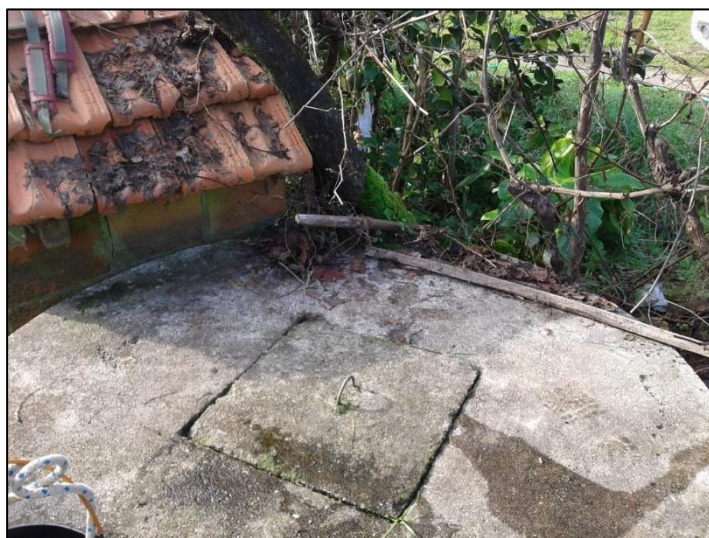
Figura 25 – Lote 4 - P3 - Poço situado ao PK 5+550
