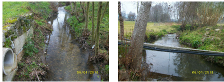
Local de monitorização S7M e S7J
