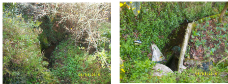
Local de monitorização S3M e S3J
