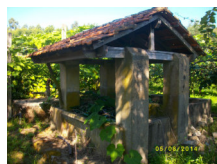
Local de monitorização P2
