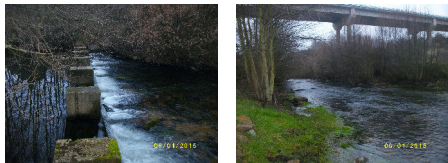
Local de monitorização S9M e S9J
