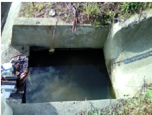
Local de monitorização ESC2
