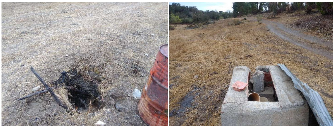
Figura 2– À esquerda poço aterrado e seco, à direita furo alternativo com características para ser monitorizado
