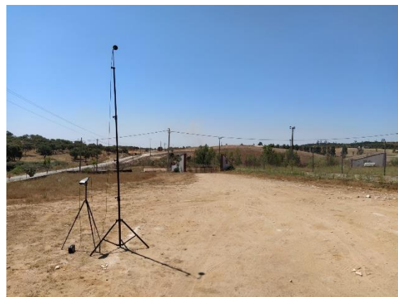
Vista de R8 para a frente de obra
