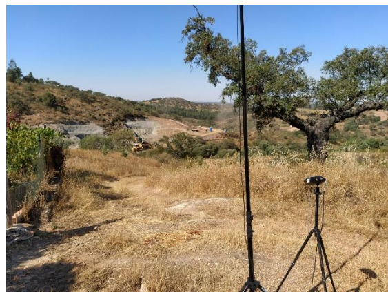
Vista de R7 para a frente de obra
