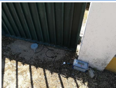
E. pK 166+100 – Pega de fogo a 17-06-2020
