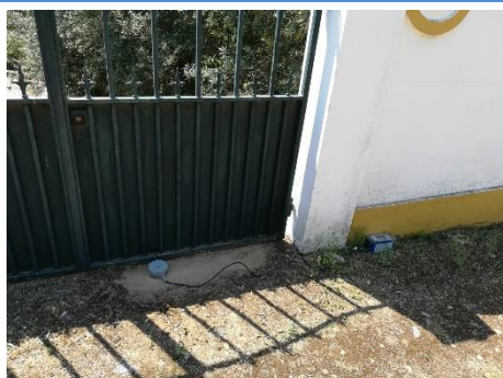
E. pK 166+100 – Pega de fogo a 26-05-2020
