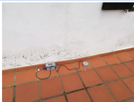
E. pK 166+100 – Pega de fogo a 15-05-2020
