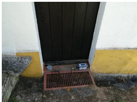
E. pK 166+100 – Pega de fogo a 20-05-2020
