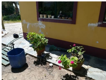
E. pK 154+300 – Pega de fogo a 22-05-2020
