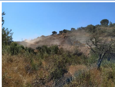
Vista de V5 para a frente de obra
