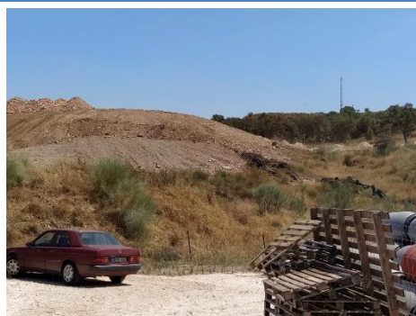
Vista de V9 para a frente de obra
