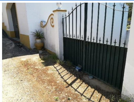
E. pK 166+100 – Pega de fogo a 29-05-2020
