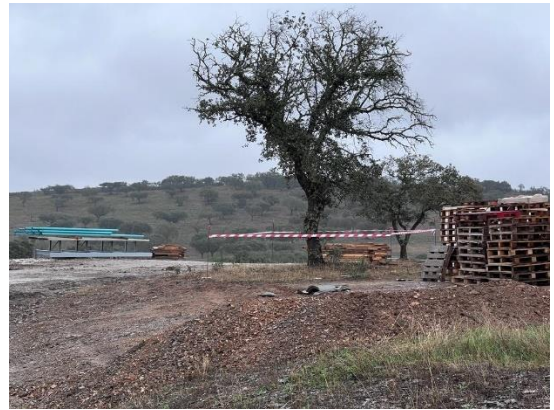
Foto 2 – Espécies arbóreas na proximidade da Obra – proteção de quercínea com fita sinalizadora
