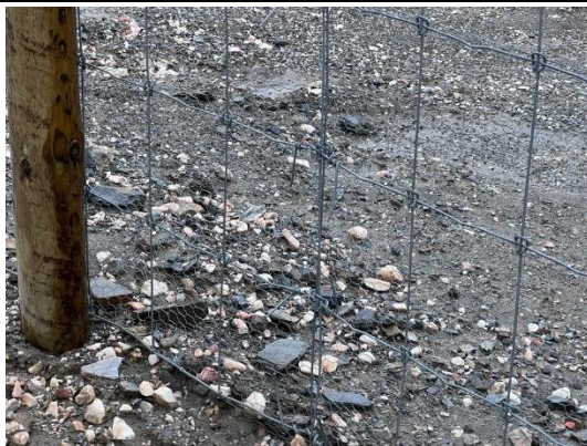
Foto 5- Rede das vedações da plataforma com segunda camada de rede de malha fina para impedir o acesso de fauna à plataforma
