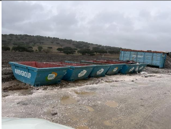
Foto 1 - aspeto geral de zonas de estaleiro – parque de resíduos
