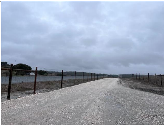
Foto 3 – Caminho de acessos locais e acesso à obra
