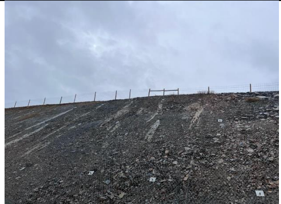
Foto 6- Aspeto geral da frente de obra com respetivos taludes
