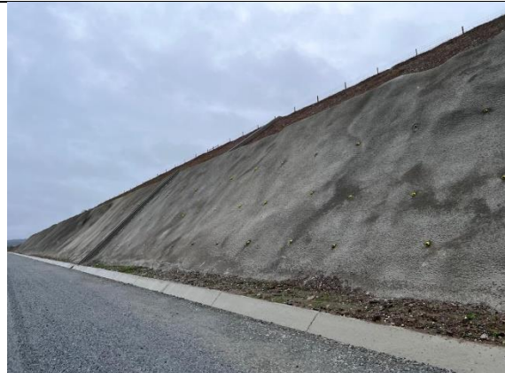
Foto 8- Vista dos taludes presentes na frente de obra e vala de drenagem de águas pluviais
