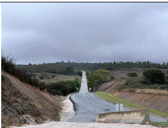
Foto 9- Aspeto Geral da frente de obra – Caminhos de Acesso
