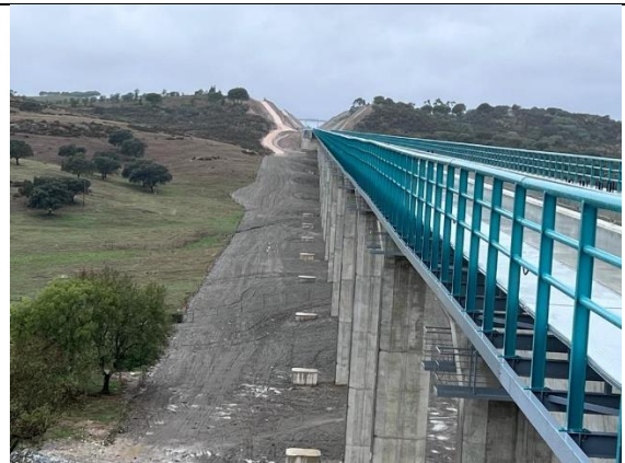
Foto 4- Aspeto geral da obra (obra de arte- viaduto)
