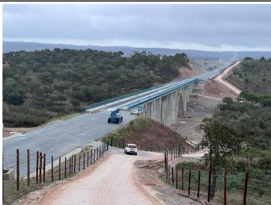
Foto 7- Vista geral dos caminhos e acessos à obra
