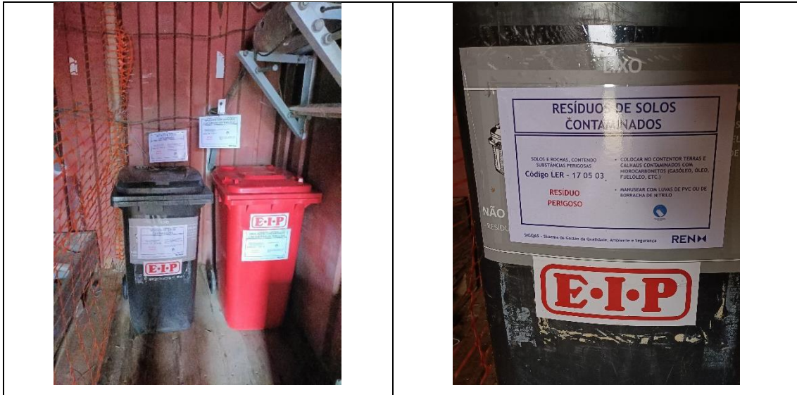
Local de armazenamento de solos contaminados em estaleiro
