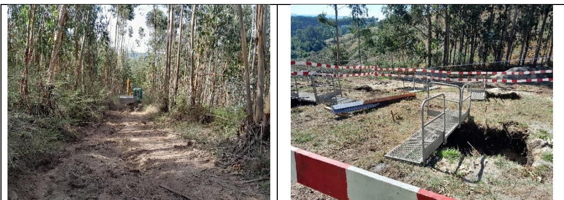
Limpeza e decapagem dos solos nas áreas de intervenção
