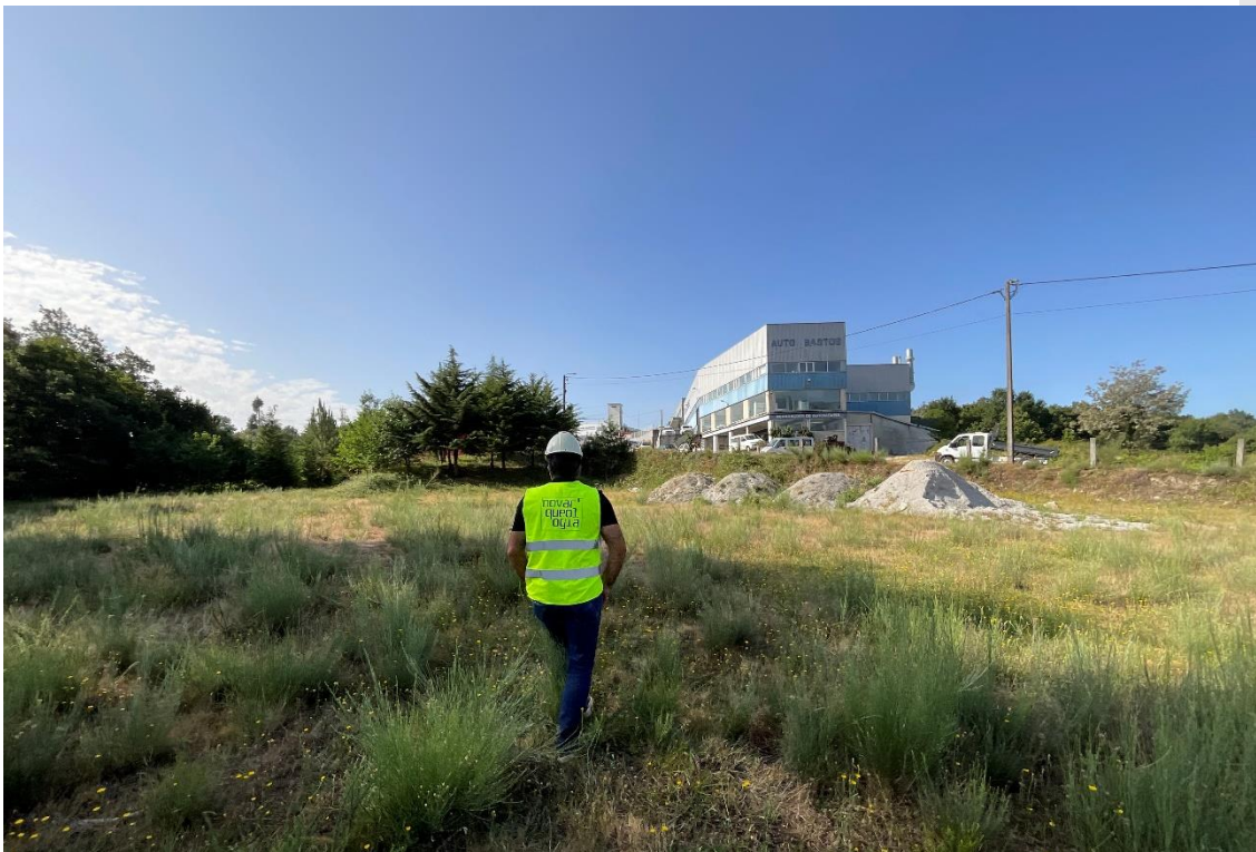
Fotografia 3: Vista geral dos trabalhos de prospeção na área proposta para a localização do estaleiro
