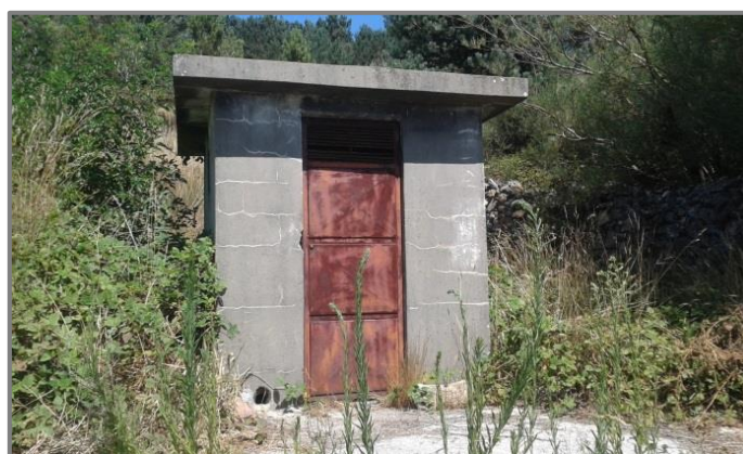
Figura 2 - Ponto de recolha 7 – Poço junto ao Km 6+700, lado esquerdo da via.
