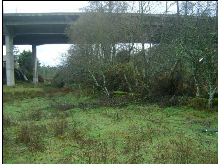
Figura 12 – Lote 7 - S6M - Ribeira do Cortiço, Viaduto 1, a montante da via
