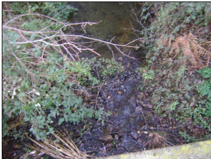
Figura 14 – Lote 8 - S7M - Ribeira da Velosa, Viaduto 1, a montante da via
