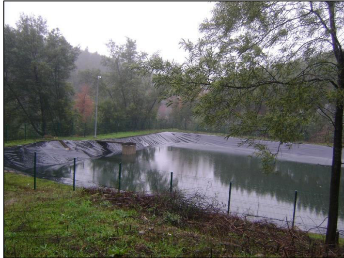
Figura 20 – Lote 1 - ESC1 - Ponto à saída da bacia de retenção/decantação projetada 1
