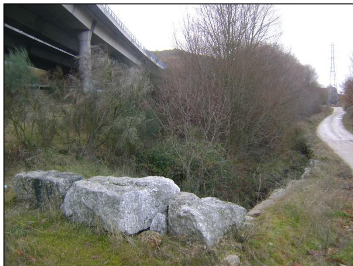
Figura 17 – Lote 8 - S8J - Ribeira de Massueime, Viaduto 2, a jusante da via
