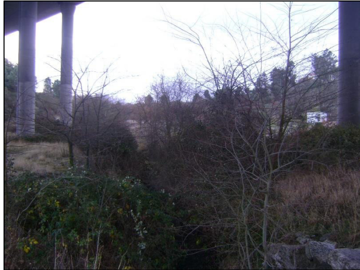
Figura 16 – Lote 8 - S8M - Ribeira de Massueime, Viaduto 2, a montante da via
