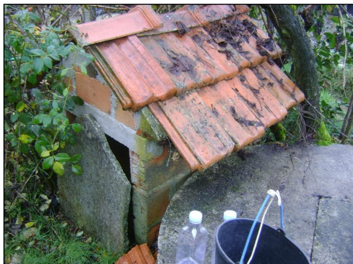
Figura 25 – Lote 4 - P3 - Poço situado ao PK 5+550
