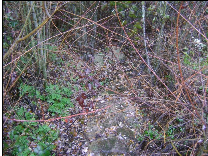
Figura 10 – Lote 6 - S5M - Ribeira das Infias, PH 20.1, a montante da via
