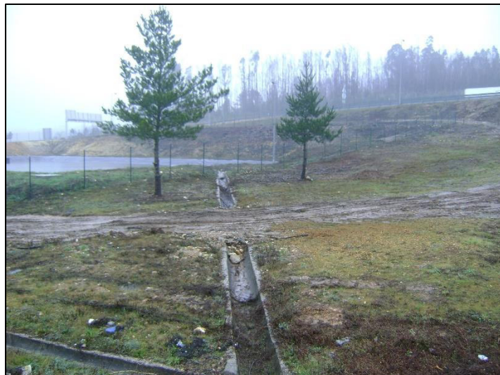
Figura 21 – Lote 1 - ESC2 - Ponto à saída da bacia de retenção/decantação projetada 2
