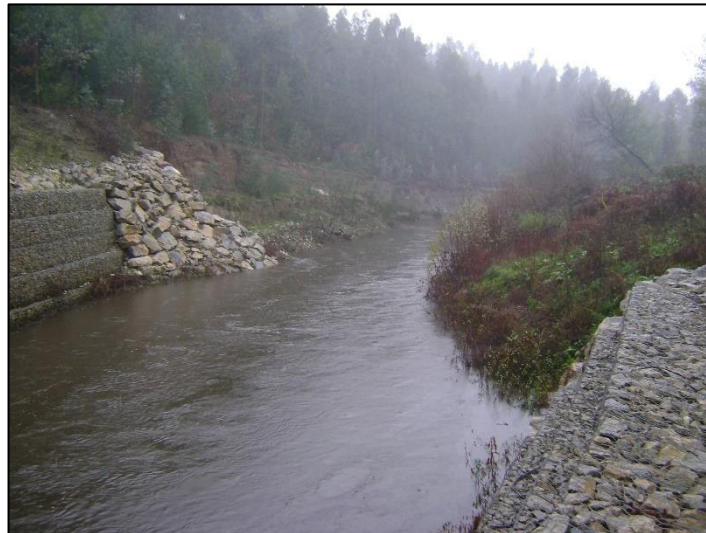
Figura 2 – Lote 1 - S1M Rio Caima, a montante da via
