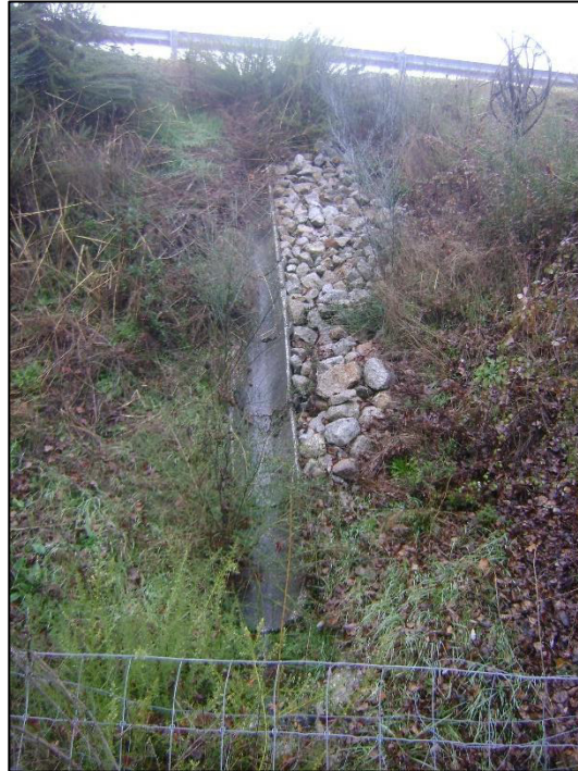
Figura 22 – Lote 4 - ESC3 - Ponto de escorrência de plataforma localizado ao km 4+125 - PH 4.1
