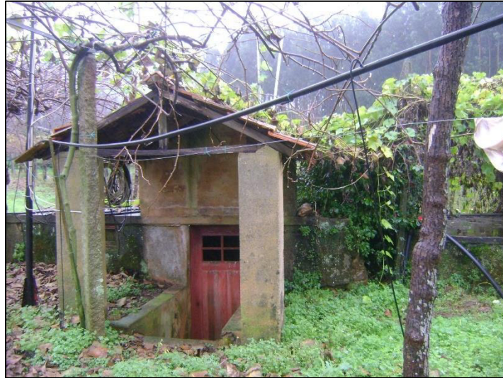
Figura 24 – Lote 1 - P2 - Poço a cerca do km 8+100, a Norte do Salgueiro
