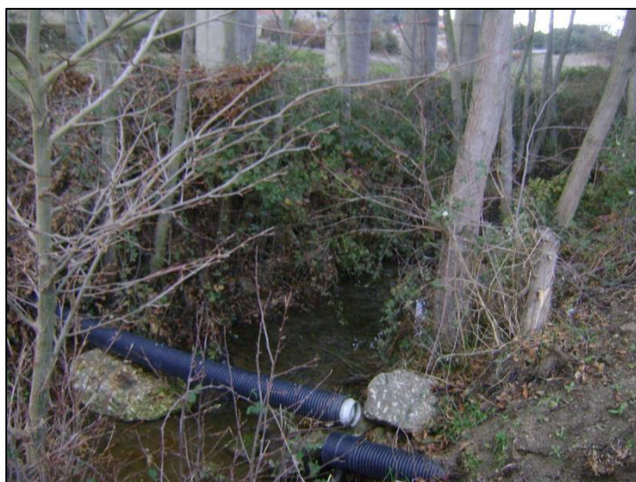
Figura 15 – Lote 8 - S7J - Ribeira da Velosa, Viaduto 1, a jusante da via
