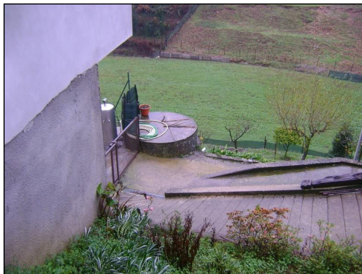
Figura 23 – Lote 1 - P1 - Poço a cerca do km 1+500, a Norte de Sernada do Vouga
