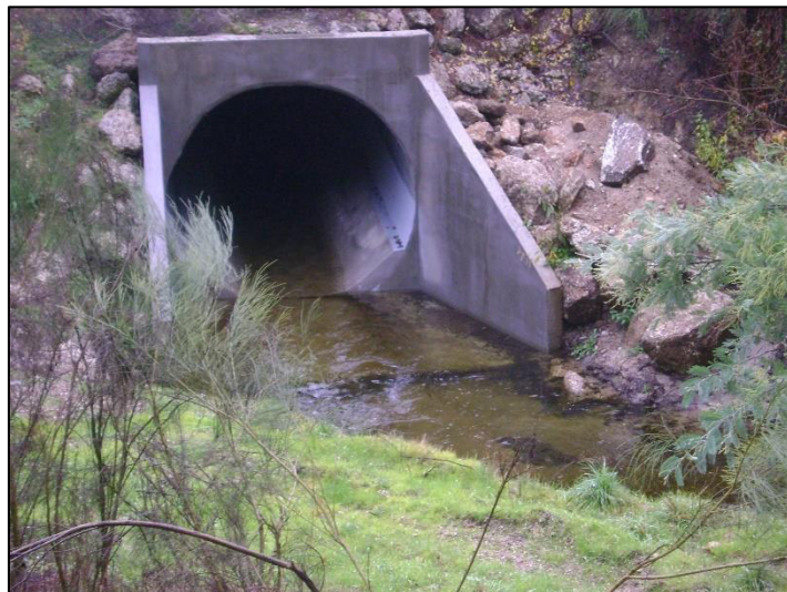
Figura 5 – Lote 4 - S2J - Ribeira do Farreco, PK 7+000, a jusante da via
