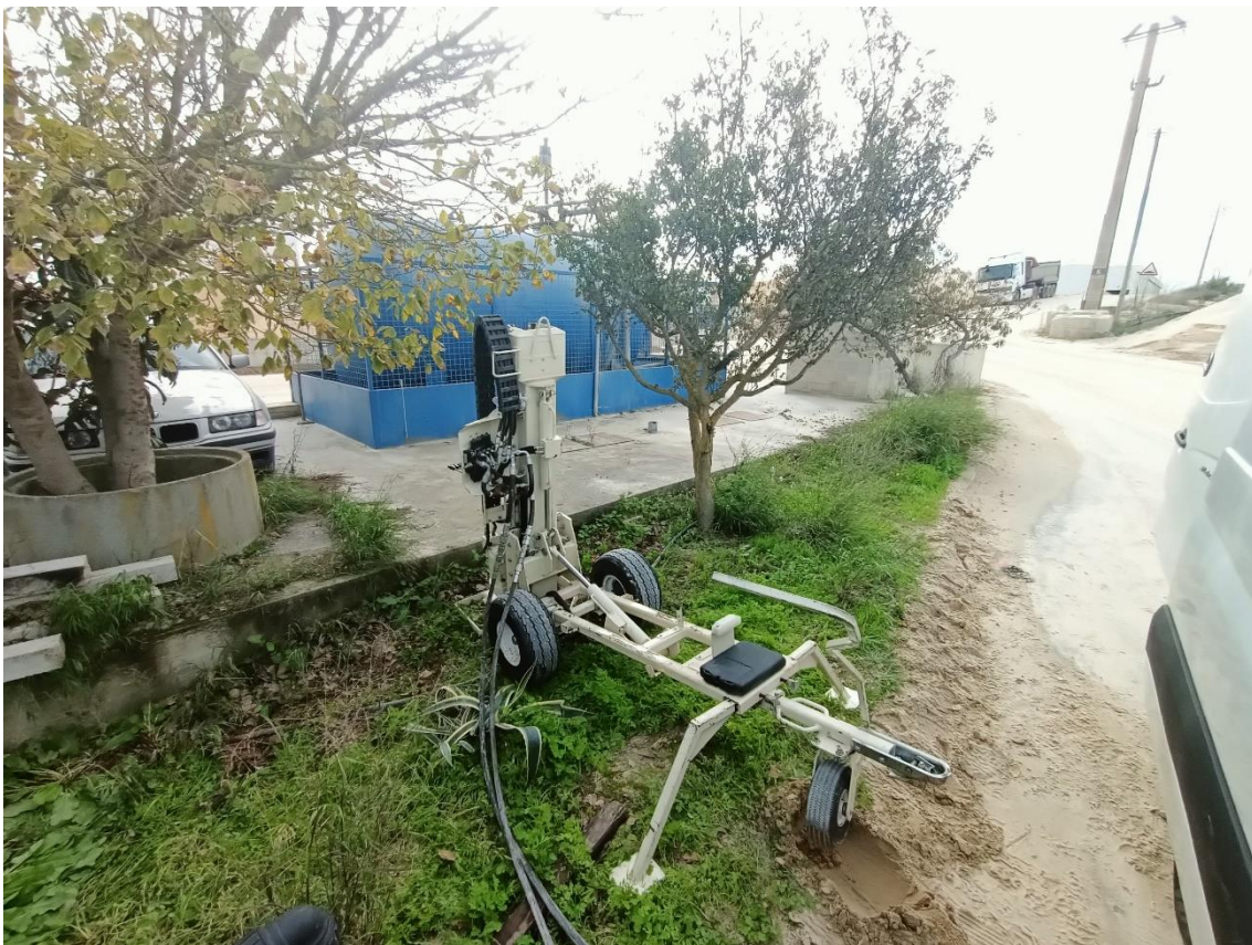
Figura 5 – Equipamento usado na execução das sondagens.
