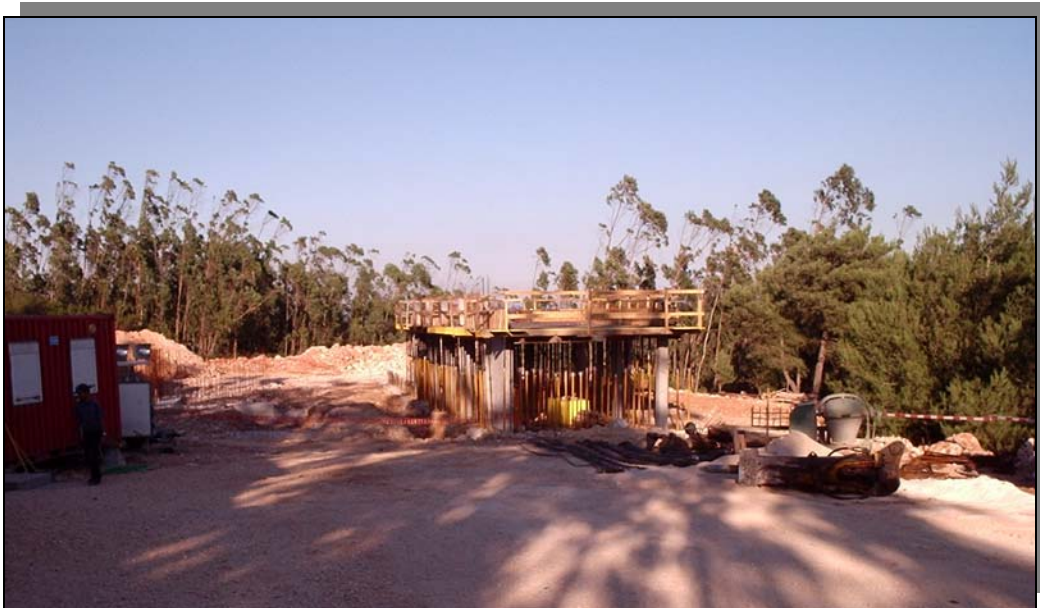
Figura 2 – Construção da subestação do Parque Eólico da Serra dos Candeeiros.
