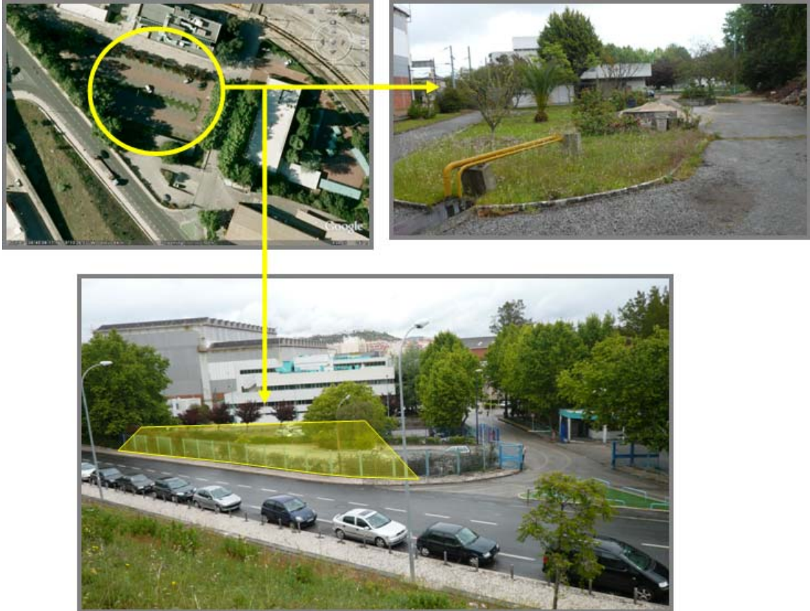
Figura 1, Figura 2 e Figura 3: Local de implantação do futuro estaleiro junto à obra da Estação da Reboleira
