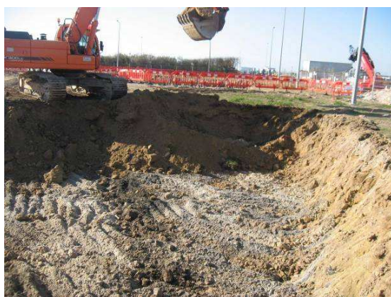
Figura 4.5 – Pormenor de uma das estacas
