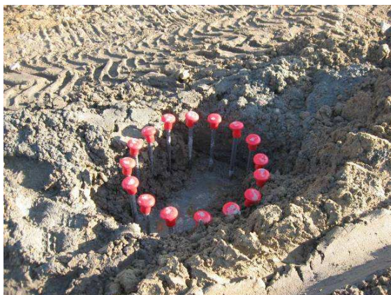
Figura 4.4 – Pormenor de uma das estacas
