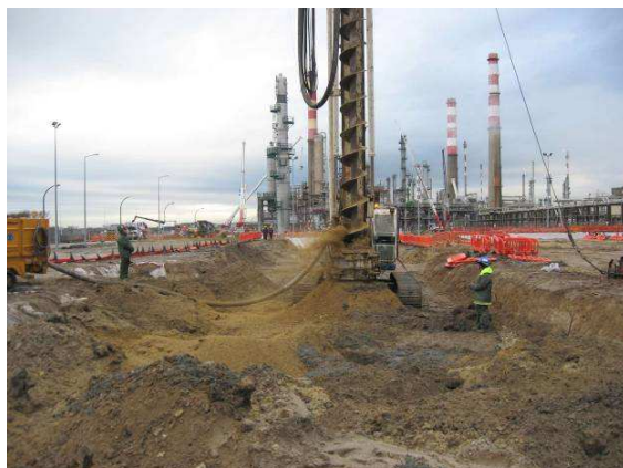
Figura 4.3 – Trabalhos de perfuração rotativa
