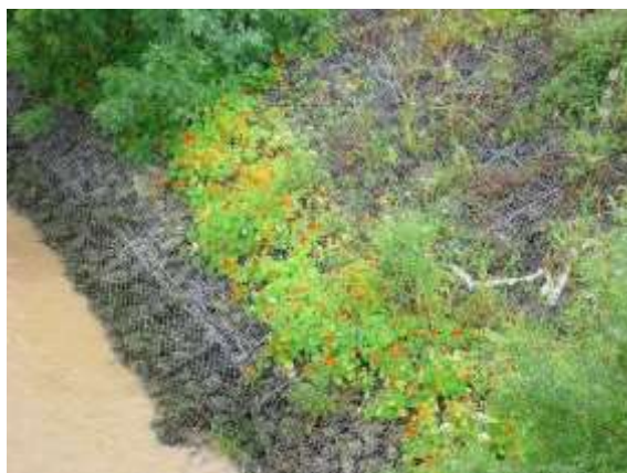
Figura 9 – Utilização de colchões Reno na estabilização de margens.
