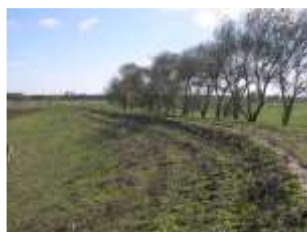
Figura 12 – Mota da vala do Risco (B)
