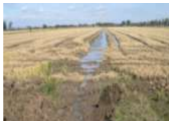
Figura 22 – Rede de drenagem
