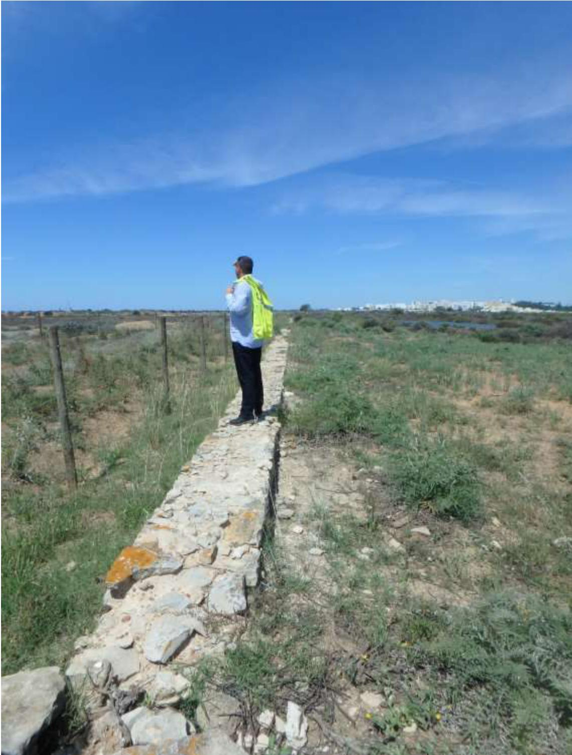
*Figura 14 – Ocorrência 3 – Muro delimitador de propriedade de aparelho construtivo com argamassa.*
