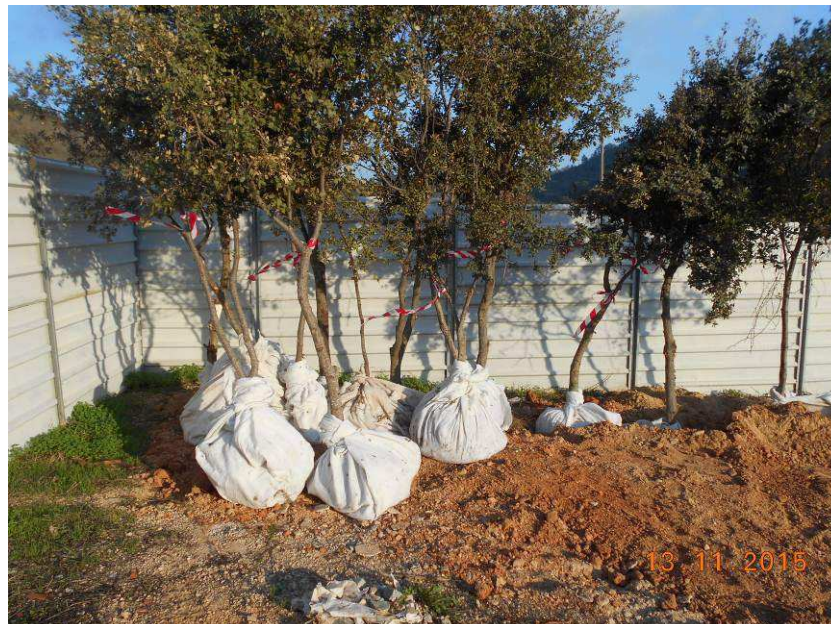
Fig. 4: Envolvimento dos torrões em geotêxtil
