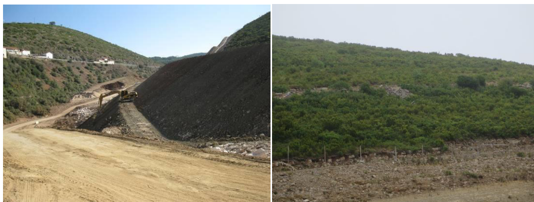
Fotografia 2.9 e 2.10 – Aspeto da construção do IC9 em fase de EIA e localização do apoio de linha elétrica sobre o talude desta rodovia em fase de RECAPE.
