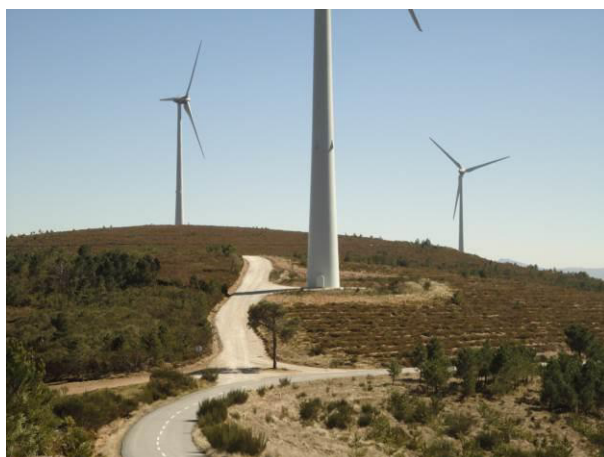
Regeneração natural da vegetação num parque eólico (zonas adjacentes ao aerogerador e caminho)
