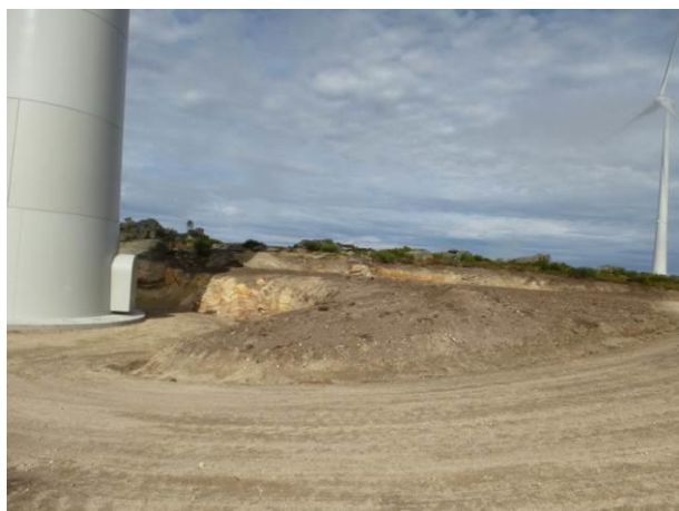
Exemplo da recuperação ambiental dos taludes junto a um aerogerador e ao longo do caminho de acesso
