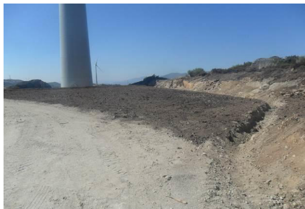
Recuperação ambiental com modelação de taludes e recuperação da plataforma de montagem de um aerogerador
