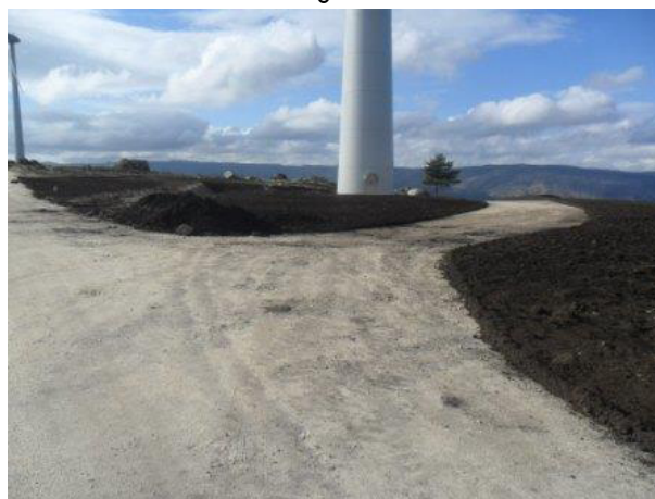
Exemplo da recuperação ambiental dos taludes junto a um aerogerador e ao longo do caminho de acesso
