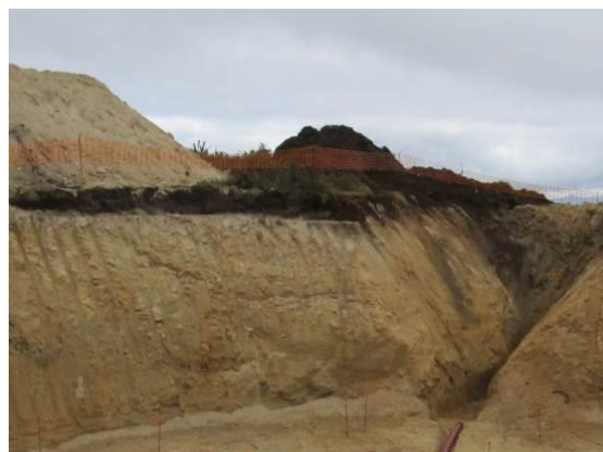
Exemplo de separação e armazenamento de terra vegetal e inertes junto a uma fundação
