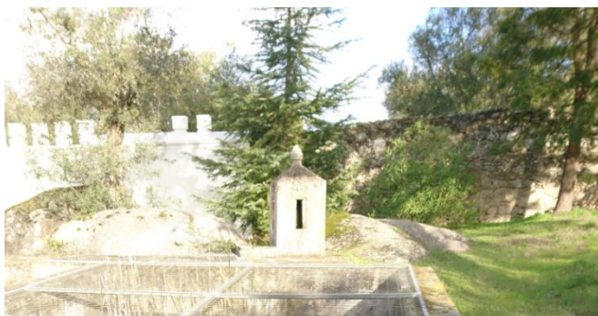
Fotografia 7 - Muro na lateral da Capela
