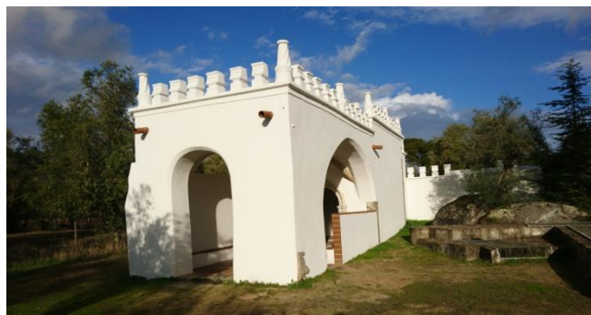
Fotografia 8 - Fachada principal da Capela com muro a nascente
