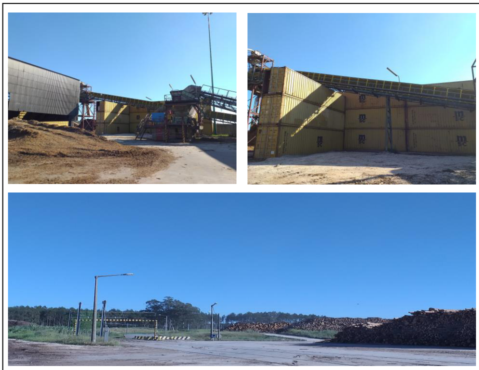
Foto 4.1 – Medidas de Controlo acústico provisórias já implementadas
