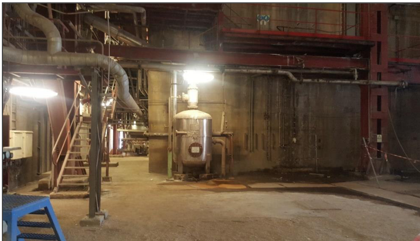
Foto 3.2 – Interior do edifício existente onde será instalada a nova caldeira a biomassa – Vista do nível de base
