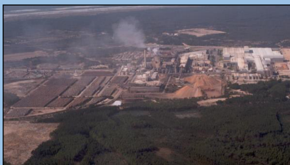
Vista do complexo industrial da Figueira da Foz
