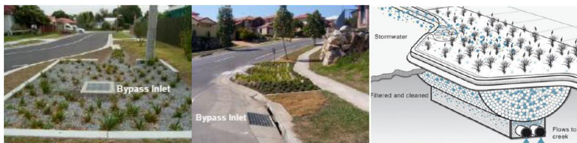
Figura 1 - Exemplos de Soluções de Drenagem Sustentável
