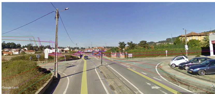
Foto 3 – Vista da EN106, no local de implantação da rotunda proposta para término da Ligação à EN106, em fase de projeto de Execução e onde a IP terá sempre que implantar uma rotunda para diminuir a sinistralidade que aqui se verifica (km 30+400 - ponto negro)
