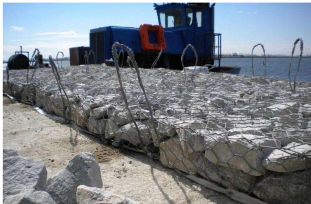
Figura 4.4– Colchões tipo “Reno” executados em estaleiro (Fonte: Projeto de Execução).
