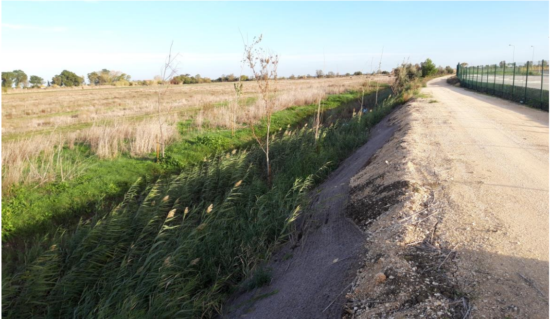
Figura 5.6- Integração paisagística na margem da vala do Carril no âmbito do projeto da Plataforma Logística de Lisboa Norte.
