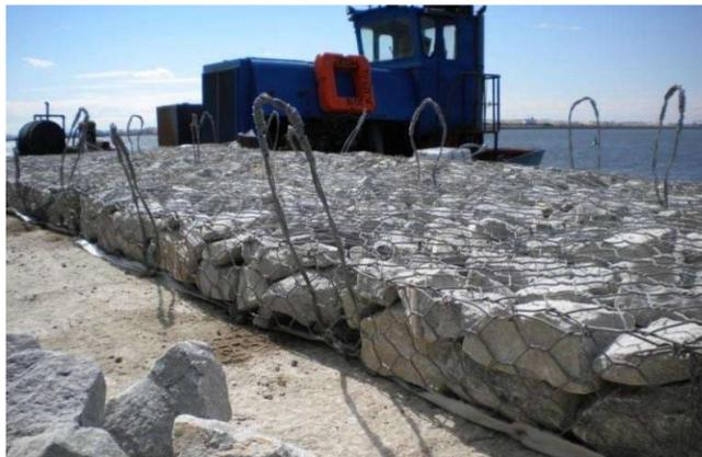
Figura 4.4– Colchões tipo “Reno” executados em estaleiro (Fonte: Projeto de Execução).
