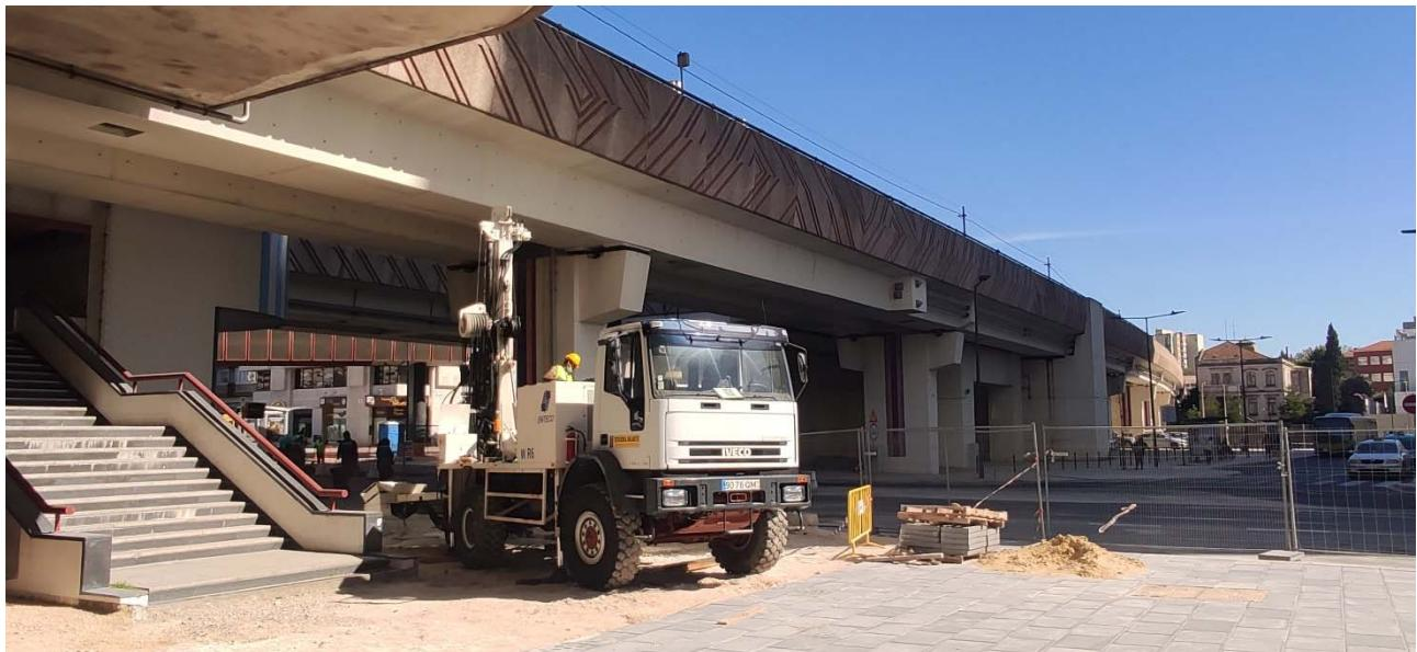
**Fotografia 1.1 – Sonda hidráulica montada sobre veículo pesado.**
