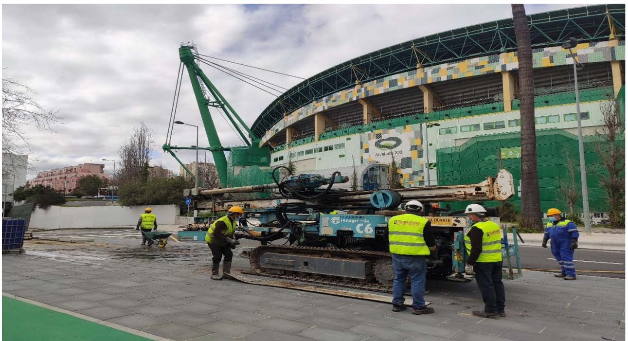
**Fotografia 1.2 – Sonda hidráulica montada sobre chassis de lagartas.**
