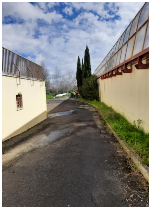
Figura 12 - Zona do encontro oeste do VL2 no encontro ao viaduto existente
