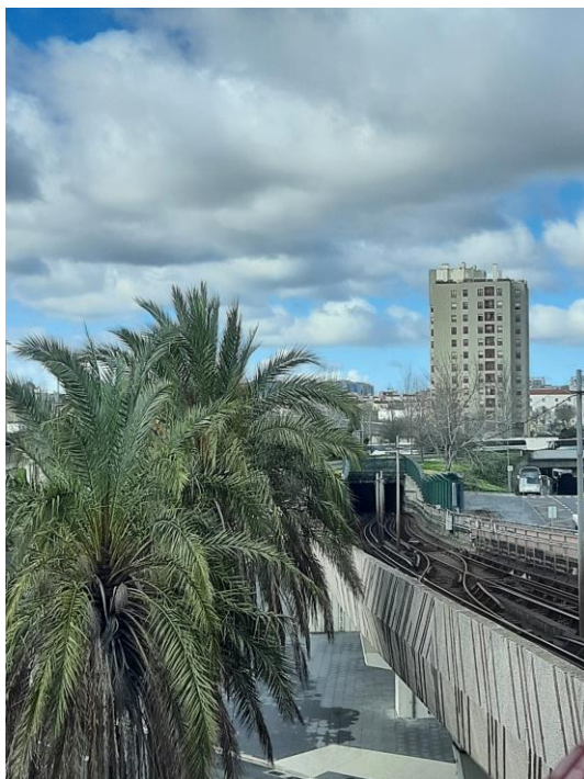
Figura 13 - Galeria do metro (construção próxima dos apoios do VL2)
