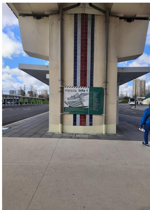
Figura 10 – Apoios dos viadutos existentes e terminal rodoviário
