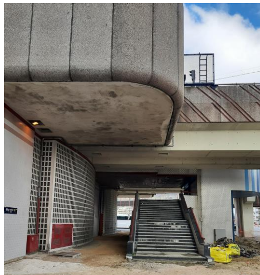
Figura 8 – Lado nascente da Estação de Campo Grande, vista sul (ampliação)
