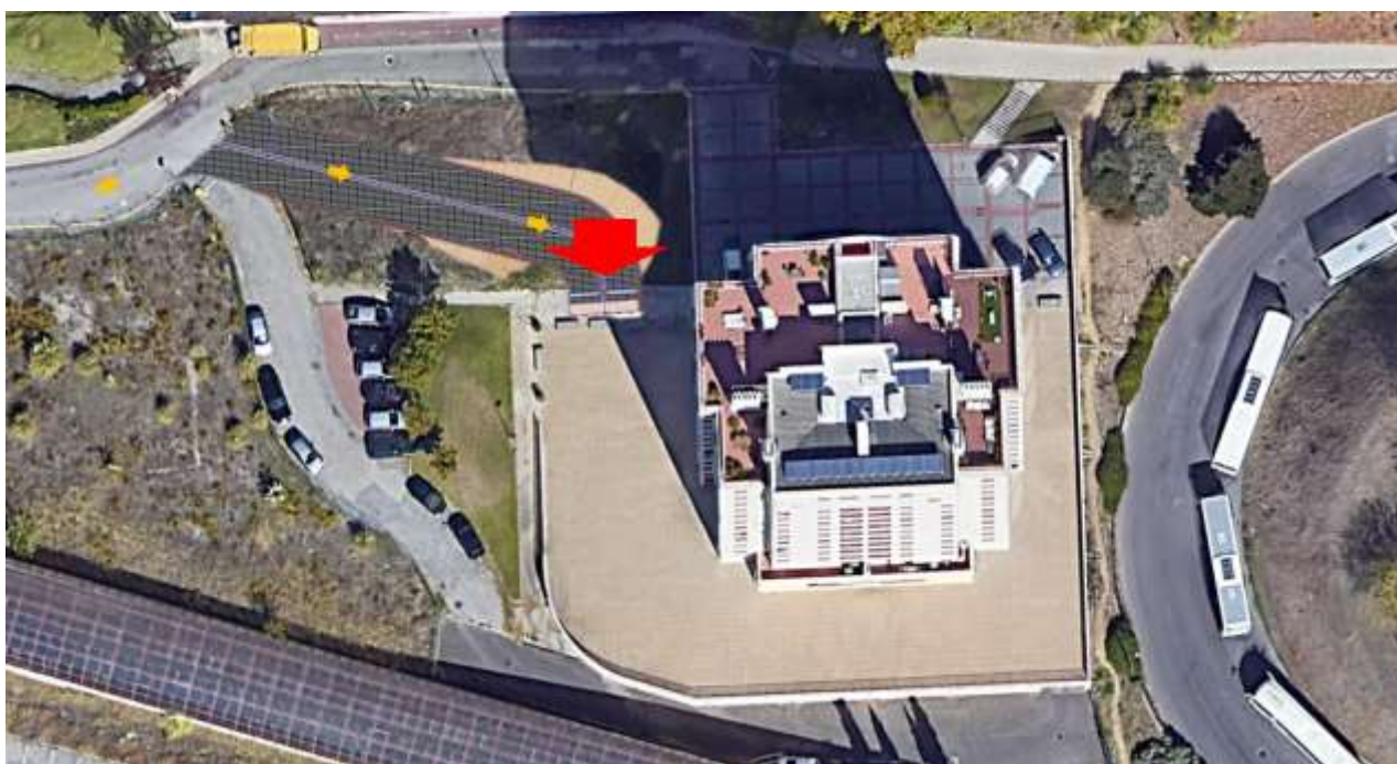
Fig. 3 – Localização do novo acesso à garagem da Torre Vicentina
