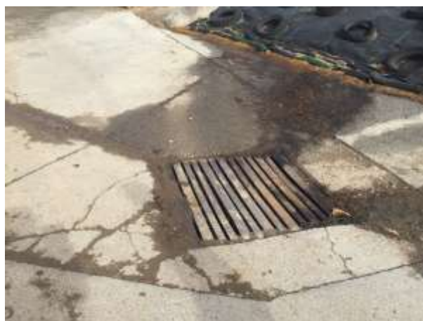
Figura 3.25– Drenagem de águas pluviais
