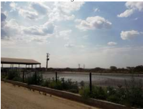
Figura 3.17 – Lagoa de retenção de chorume (Lagoa 2)
