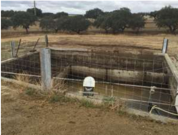
Figura 3.15 – Tanque de recepção de chorume com homogeneizador
