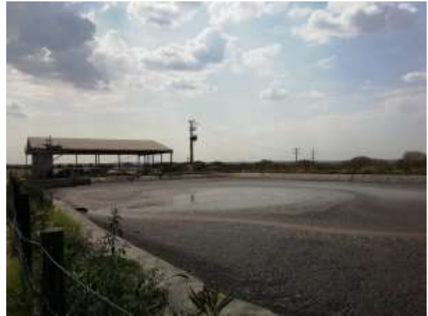
Figura 3.16 – Lagoa de retenção de chorume (Lagoa 1)
