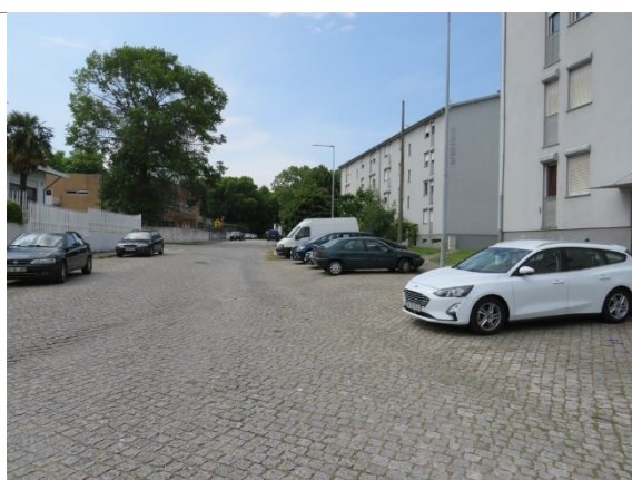
Rua Gonçalves Cabral, com desvio de trânsito na fase de construção.
