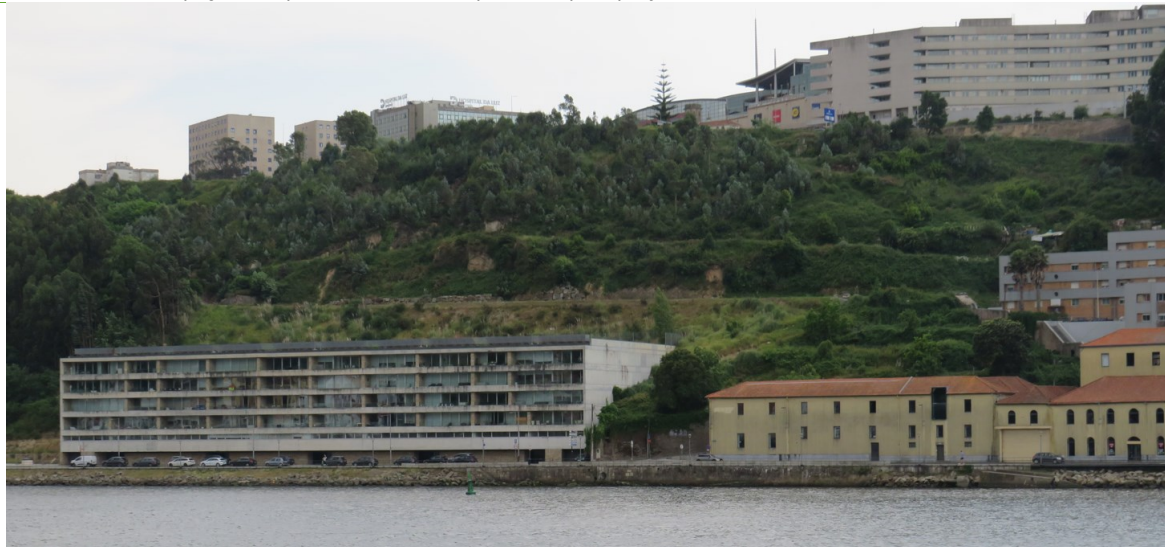
Vista de conjunto da área de implantação do encontro sul da Ponte sobre o rio Douro.
