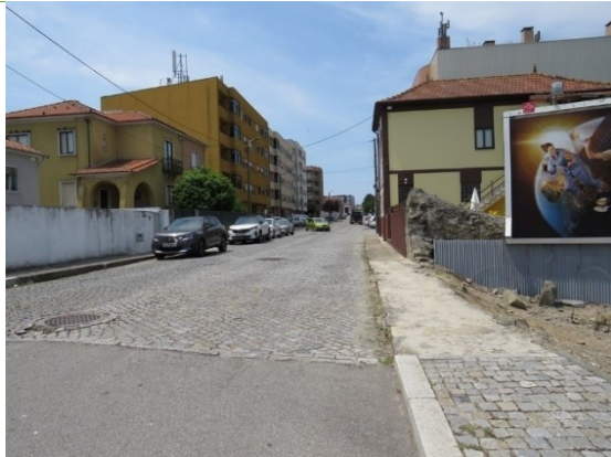
Área de ocupação permanente com expropriação de edifício (lado direito) e três edifícios de habitação já não afetados em PE (lado esquerdo). Rua André de Castro.
