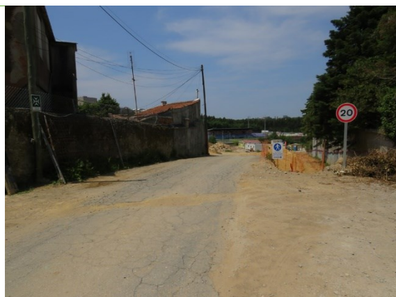
Vista da Rua 28 de Janeiro, no sentido campo de jogos e área prevista para estaleiro (2).
