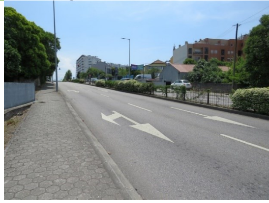
Vista para lado poente da VL8, entre Rua Grémio da Prosperidade e Rua André de Castro, com área de ocupação permanente / expropriação a afetar conjunto de edifícios.
