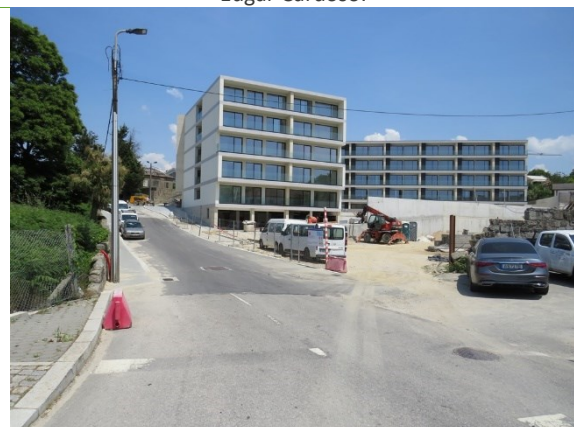
Vista para desenvolvimento de construções na Rua 28 de Janeiro e junção com a Rua Clube Desportivo do Candal (5).
