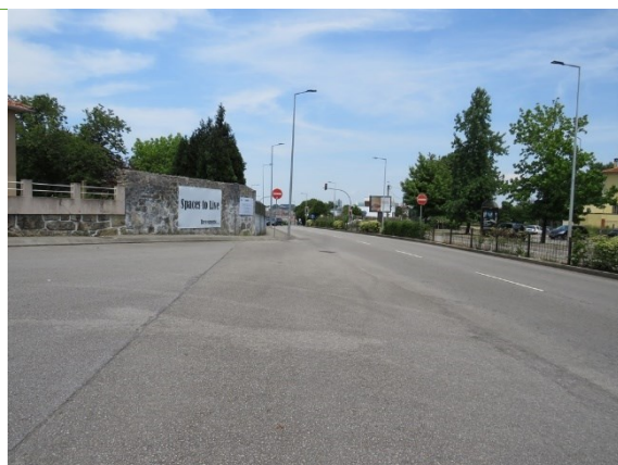
Vista para junção da Rua Castro Portugal, com edifício de habitação em área de ocupação permanente /expropriação, cartaz e aviso de pedido de licenciamento de obras de construção.
