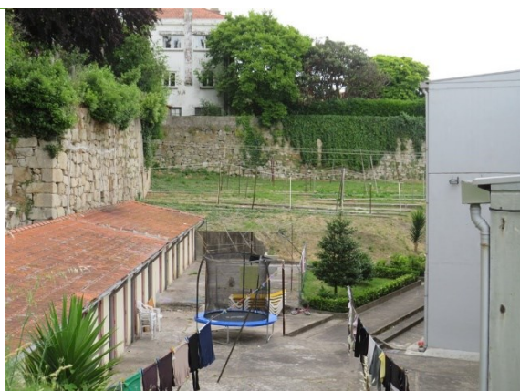
“Pequeno edifício” de arrumos, com potencial demolição e reconstrução.
