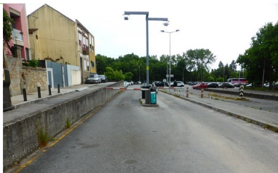
Parque de Estacionamento Campo Alegre-Porto. Local da saída da Estação Campo Alegre para a Rua do Campo Alegre. Área de ocupação definitiva.
