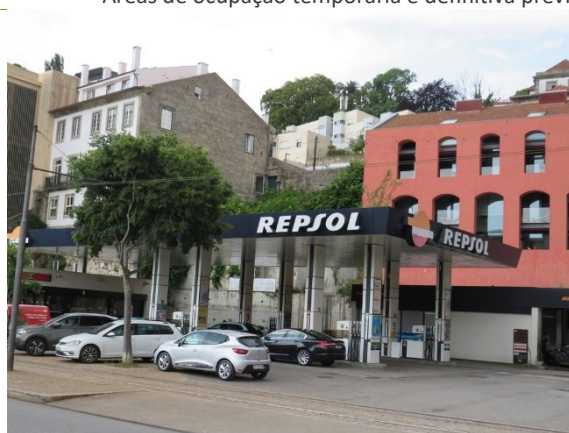
Enquadramento da área a ocupar pelo pilar P4 e maciço de ancoragem lado Porto. Ocupação definitiva.
