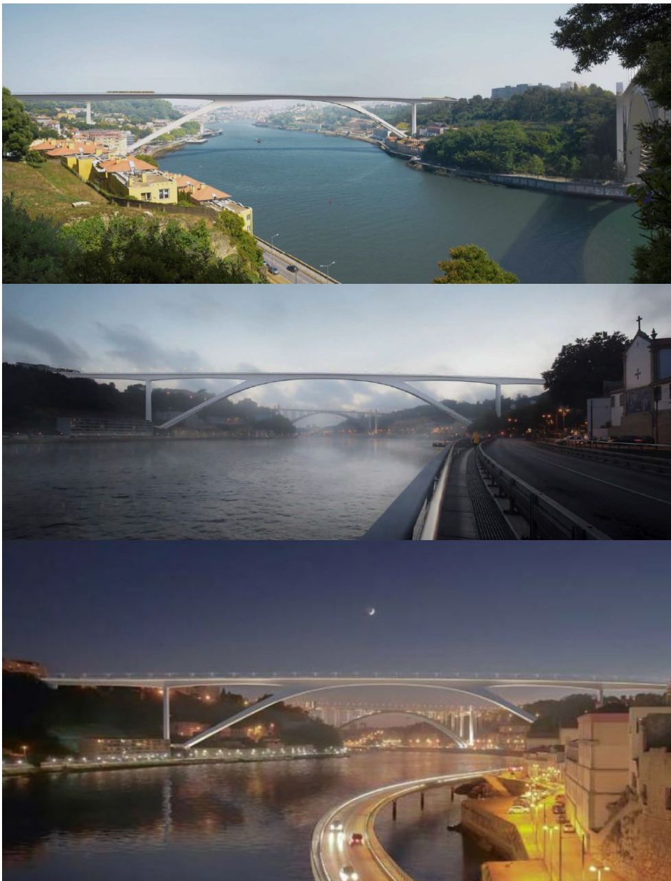
Figura 6.30 - Aspectos gerais do novo atravessamento do Douro.
