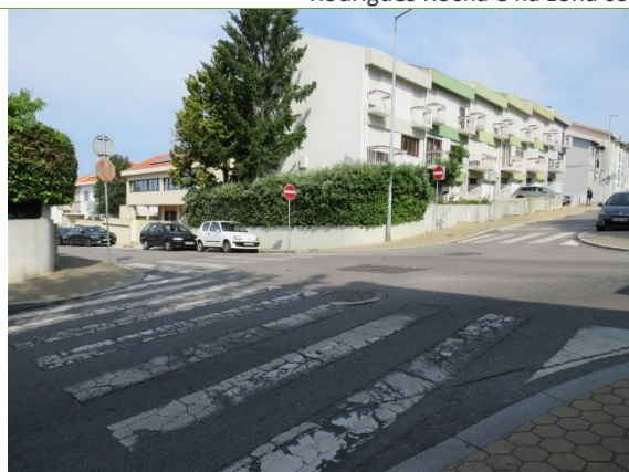
Rua António Rodrigues Rocha, com afetação permanente de cinco edifícios unifamiliares. Vista no sentido Rua Fernão Mendes Pinto (sul) para Rua Diogo Couto (norte).
