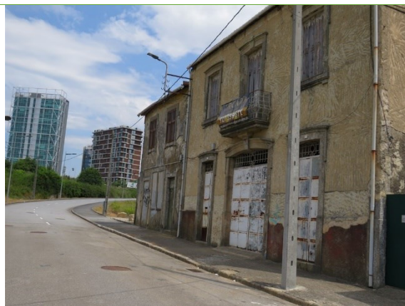
Vista do final da área de intervenção na Rua José Falcão, sem afetação de edifícios (VNG_RJT_807; VNG_RJF_815).
