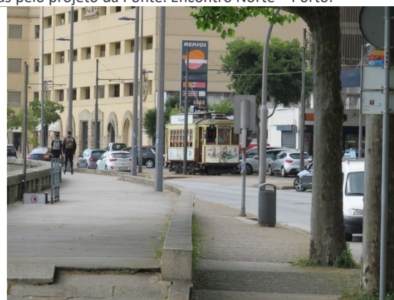
Detalhe do Carro Elétrico da Linha 1 dos STCP, com afetação tipo interrupção de circulação, na Praça de Chegada da Ponte.
