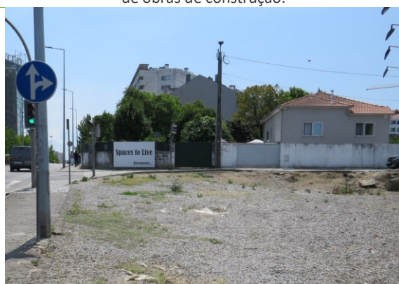
Vista para área de ocupação permanente, a partir da Rua André de Castro, com cartaz de futuro empreendimento (maio de 2023). Ao lado, edifício isolado (VNG_RAC_418), que deixou de ser afetado em fase de PE.
