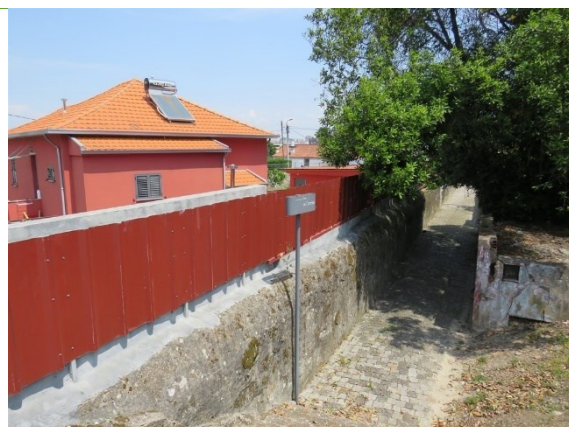
Vista para Viela do Corredor, sentido Rua Castro Portugal, com edifício e anexo em área de ocupação permanente / expropriação.
