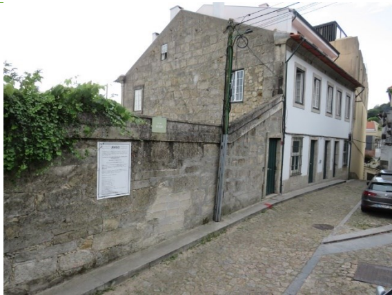
Rua do Bicalho e lote desocupado cuja área terá uma afetação definitiva para Praças / Zona de Chegada.
