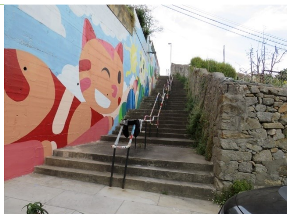
Detalhe do estado atual da escadaria da Boa Viagem (vista para Calçada da Boa Viagem).
