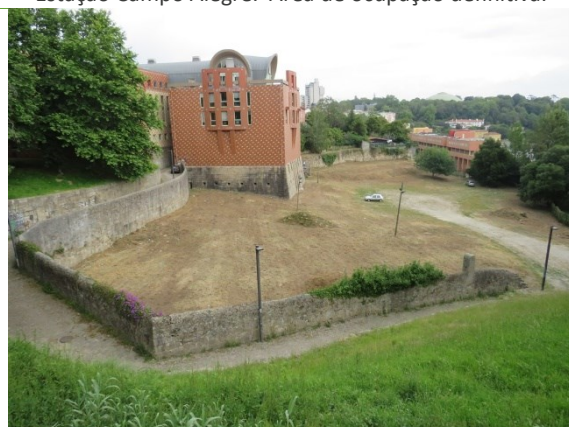
Área de estacionamento de utilização pública, entre a Faculdade de Letras e a Residência Universitária Alberto Amaral, com acesso pela Rua do Golgotá e Rua da Pena. Sem ocupação prevista pelo projeto.
