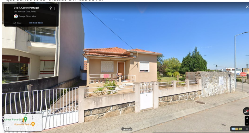
Edifício de habitação unifamiliar em área de ocupação permanente e muro com afixação de Aviso. Imagem Google Street View, datada de julho de 2022.
