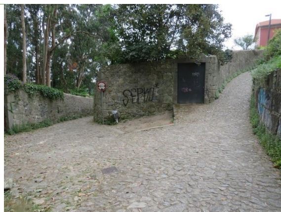
Enquadramento da junção da Rua do Gólgota (ligação à Via Panorâmica) com Rua da Boa Viagem / Travessa do Gólgota (sentido estacionamento junto à FLUP).
