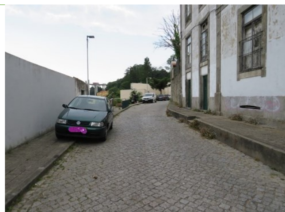
Enquadramento da área de intervenção para o encontro da Passarelle, Calçada da Boa Viagem.
