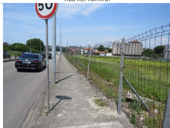
Estação Candal – área de ocupação definitiva VL8. Zona de ocupação temporária para estaleiro – Lado nascente da VL8.
