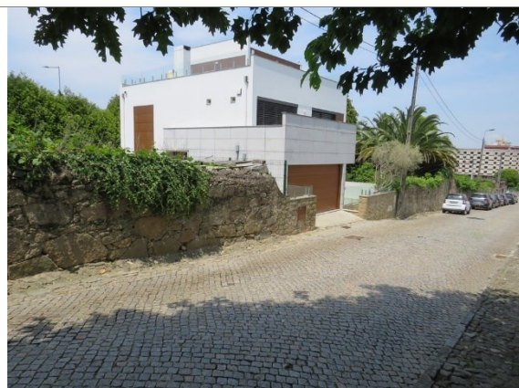
Área de ocupação permanente / expropriação de edifício na Rua Castro de Portugal.
