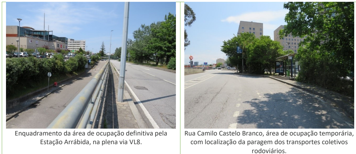
Figura 6.78 – Enquadramento da área de ocupação definitiva pela Estação Arrábida e ilustração de áreas dos trabalhos na rodovia, na Fase 1. Registo fotográfico atual
