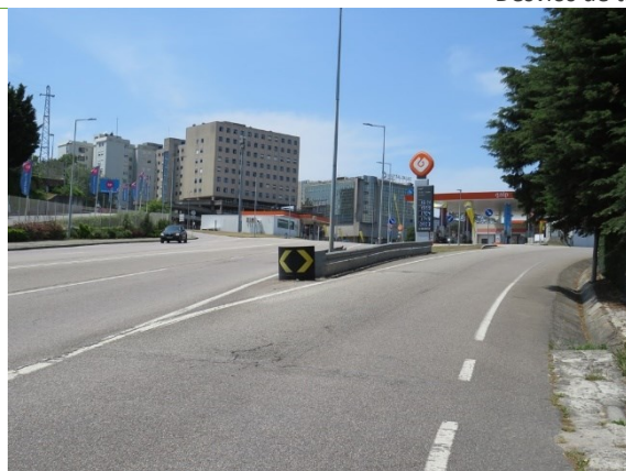
Enquadramento da entrada de plena via ao posto de abastecimento, no sentido sul/norte, a encerrar e a processar-se a partir do ramo de ligação.
