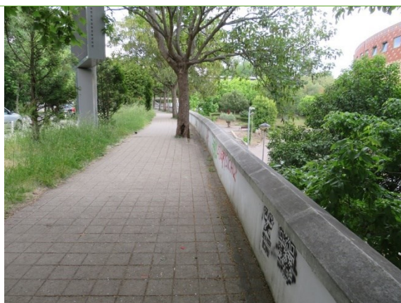
Muro da Faculdade de Letras, com inversão da área ajardinada e área pavimentada. Área de ocupação temporária.
