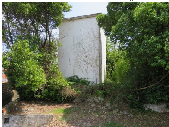
Estrutura, tipo antigo PT, a norte do edifício, em área de ocupação permanente.
