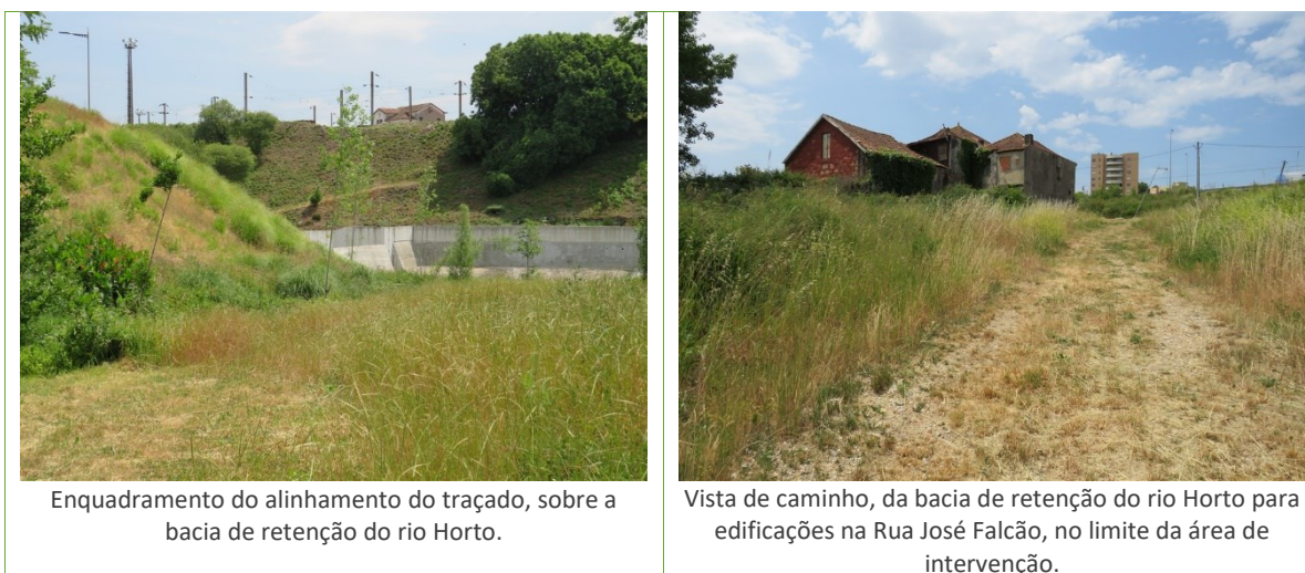
Figura 6.97 – Enquadramento das áreas de ocupação entre a Rotunda Eng. Edgar Cardoso e a Bacia de Retenção do rio Horto
