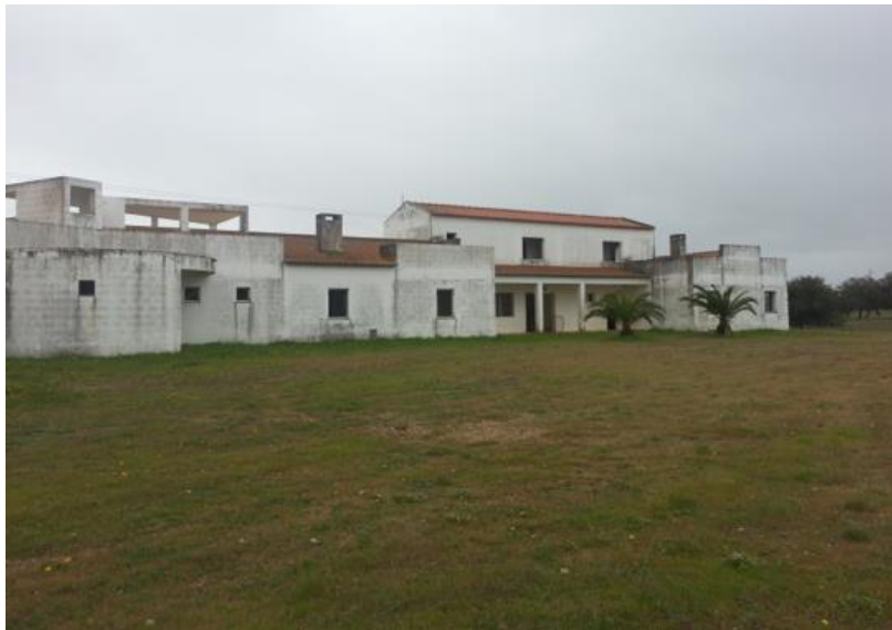
Fotografia 3.2 – Edifício existente no antigo Kartódromo de Serpa que será sujeito a reconversão e ampliação
