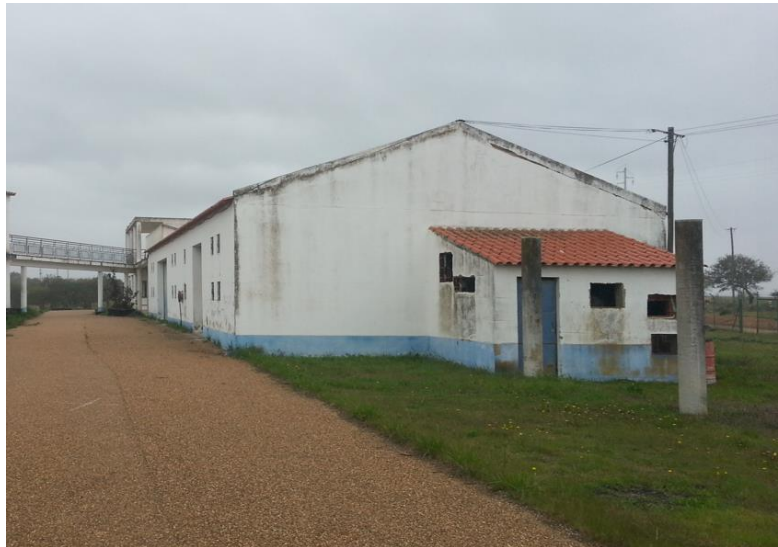
Fotografia 3.4 – Edifício existente (futuro Armazém de Logística/garagem) no antigo Kartódromo de Serpa, adjacente ao futuro Clubhouse e que será sujeito a reconversão e ampliação
