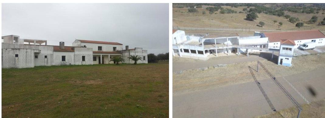
Figura 4.2 - Edifício existente no antigo Kartódromo de Serpa que será sujeito a reconversão e ampliação
