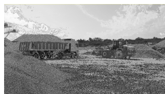
Expedição (ruído gerado pela circulação de viaturas pesadas que procedem ao transporte dos materiais)
