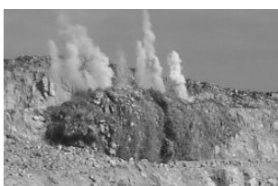
Detonação (ruído gerado, essencialmente, pelos movimentos do terreno, pela libertação de gases, pela detonação do cordão detonante e pela colisão de pedras)
