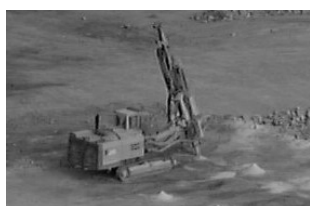
Perfuração (ruído gerado pela interação broca/rocha e pelo funcionamento da perfuradora)
