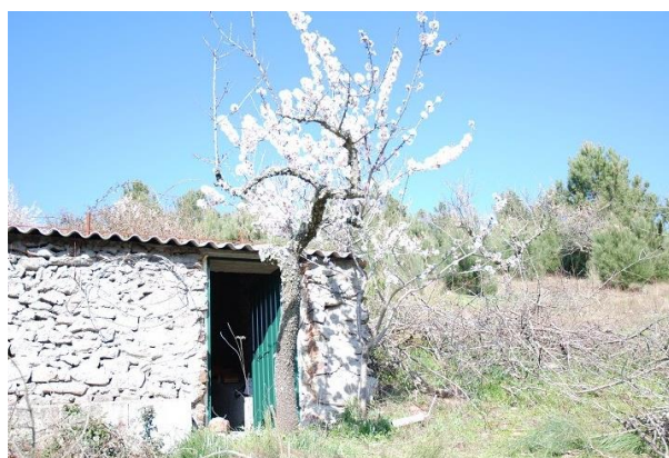
Figura 9 - Construção de apoio agrícola referente ao P11
