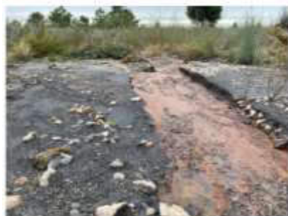
B - Barragem de lamas fora da concessão, 22.10.2023
