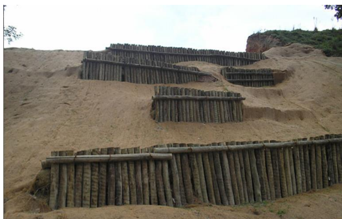
Figura 3.3.28 - Tipo de muros (paliçadas) a executar
