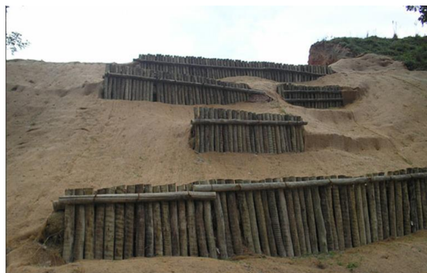
Figura 4.5.41 - Tipo de muros (paliçadas) a executar
