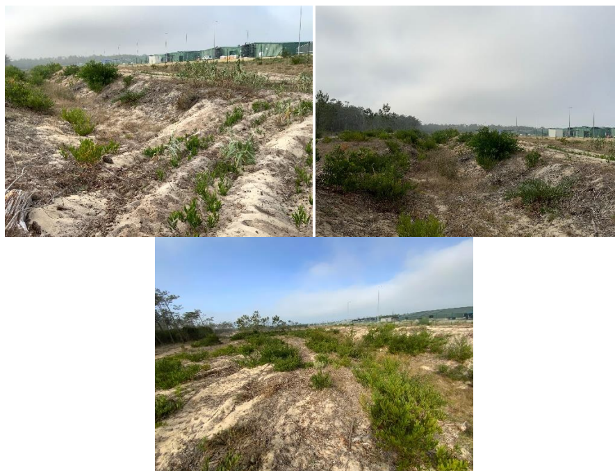
Figura 4.3.6 - Vala atual (Imagens de 11.10.2023)
