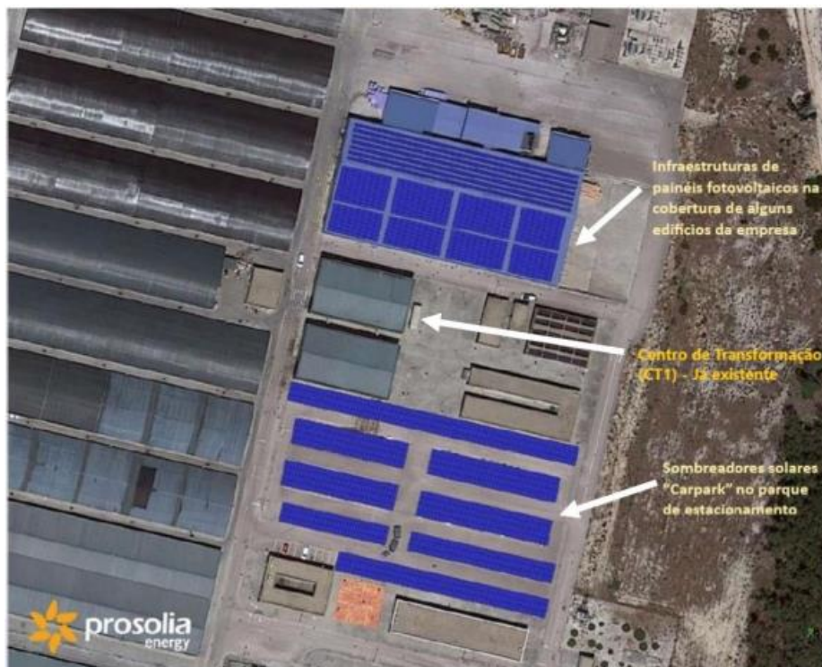
Figura 2.1.2 - Infraestruturas implantadas de fotovoltaico para autoconsumo (PROSOLIA, 2021)
