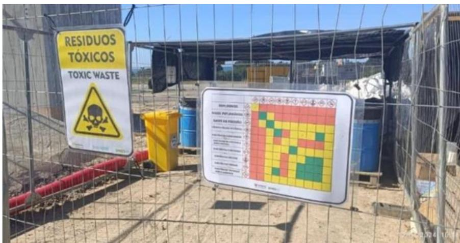
Figura 105 - Evidência Fotográfica de resíduos perigosos no Parque de Resíduos: os contentores são mantidos afastados de cursos de água, fechados, tapados, identificados e elevados do solo, a área é delimitada, existe extintor de incêndio e kit de derrame.
