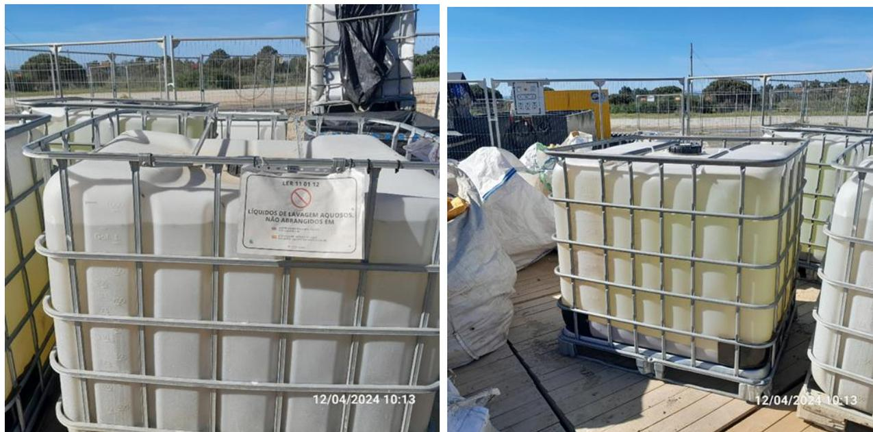
Figura 102 - Evidência fotográfica de colocação em depósito estanque, sobre terreno impermeabilizado, antes de serem encaminhadas para destino final adequado pela Ambigroup.
