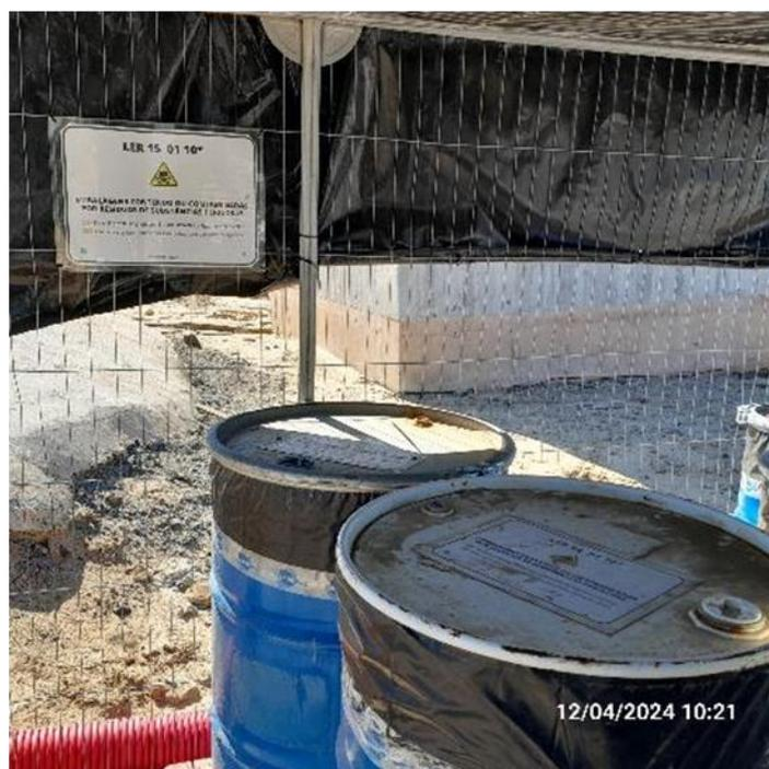
**Figura 104 - Evidência fotográfica do correto armazenamento em obra (NEST ou Sin01) de resíduos suscetíveis de gerar efluentes contaminados pela ação da percolação das águas pluviais.**
