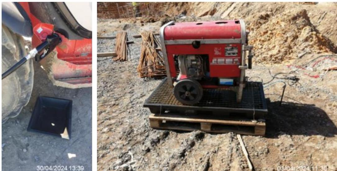
**Figura 108 - Evidência fotográfica de medidas preventivas para controle de fugas.**
