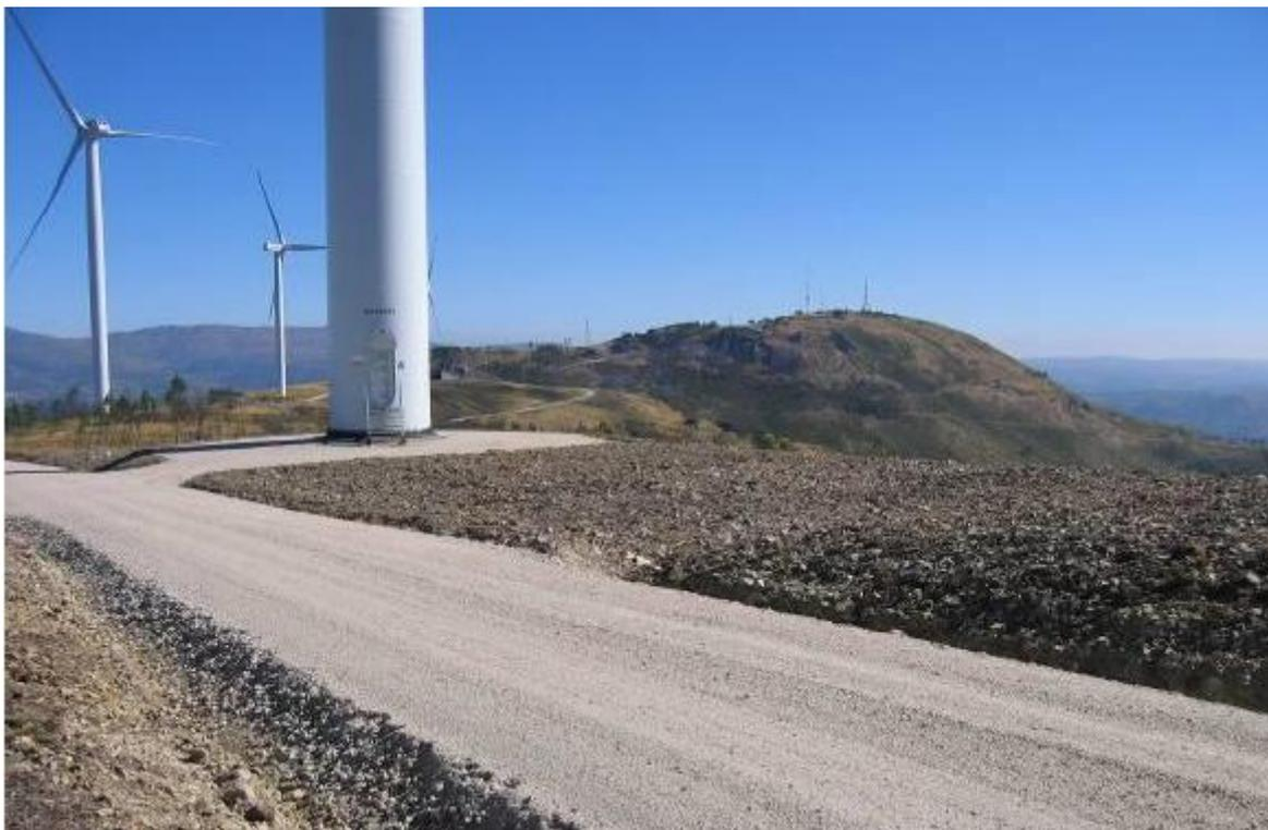
**Figura 4:** Exemplo do aspeto de uma plataforma após renaturalização.
