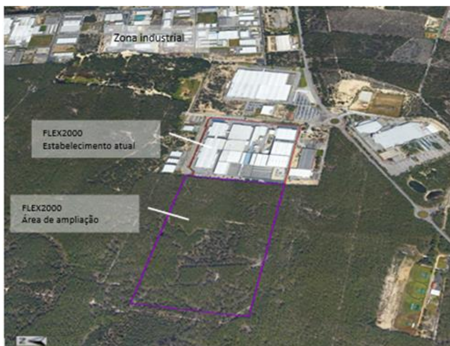
Figura 1- Imagem aérea da área na qual se identifica o estabelecimento atual e a área de ampliação.
