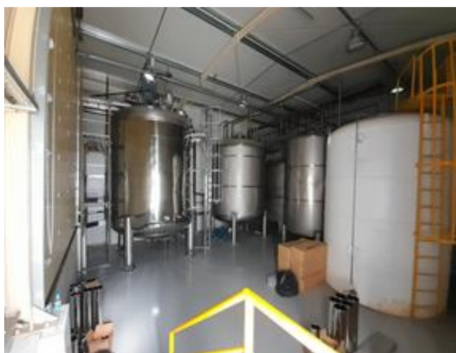
Figura 4.9 -Interior da sala de cisternas III.
