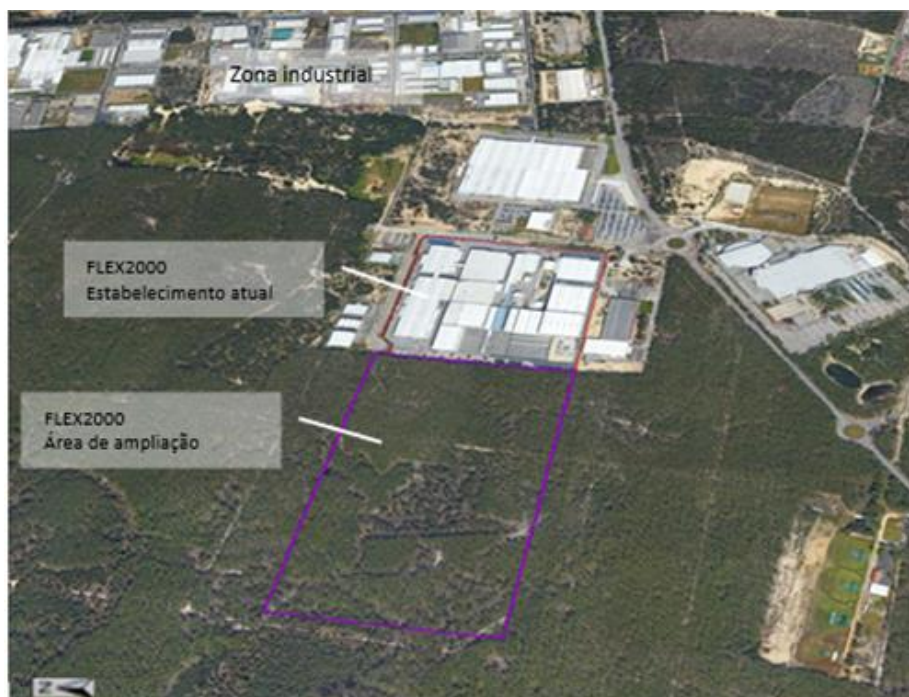
Figura 2.1 – Imagem aérea da área na qual se identifica o estabelecimento atual e a área de expansão.
