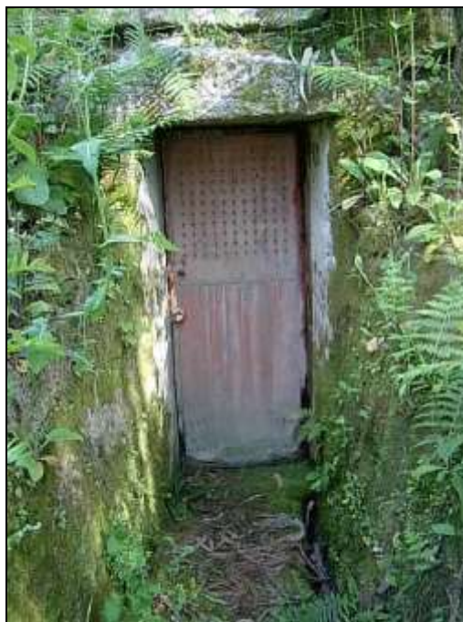
Fotografia 7 – Porta da Mina 18
