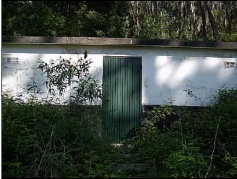
Fotografia 19 – Repartidor da Presa Nova (ref.44)
