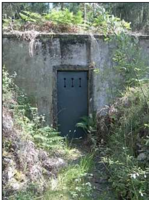
Fotografia 5 – Porta da Mina 15
