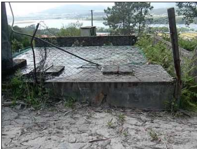
Fotografia 10 – Reservatórios 31, 32 e 62 e Presa de Rega ref.23
